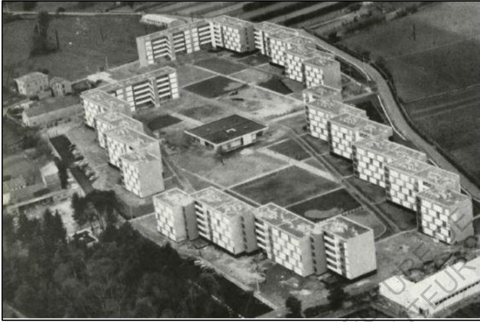
Figure 35 : Vue d'ensemble de la citadelle-77
