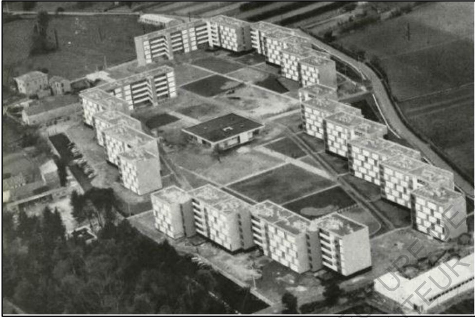
Figure 35 : Vue d'ensemble de la citadelle-77
