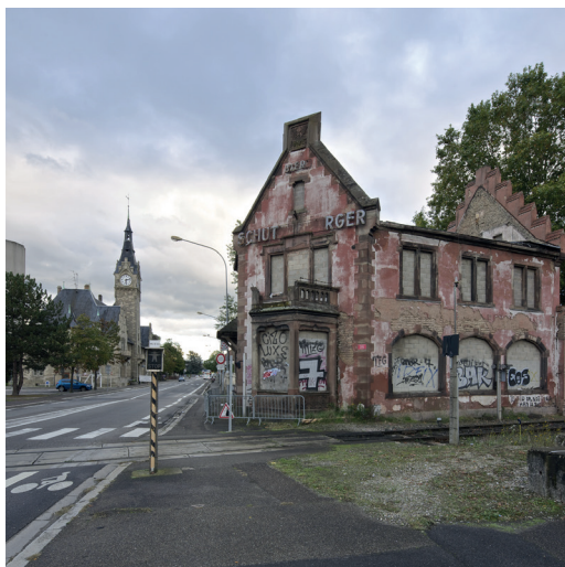
1. Maison Schutzenberger (1899) Crédit photo: A. Chemetoff & Associés
