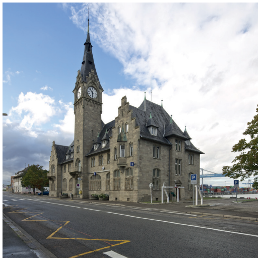
1. Capitainerie (1899) Crédit photo: A. Chemetoff & Associés
