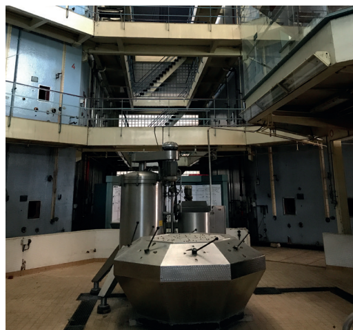
Photo1 : Salle des Cuves, installation en pointe à l'époque située dans le bâtiment de la Cave à Vin. Source: apport personnel.
