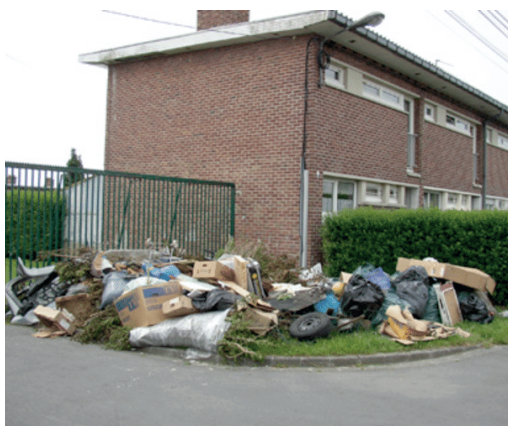
Photo 3. Dégradation des bâti de type maisons mitoyennes ainsi que des conditions de vie au sein du quartier Source: Bazar Urbain. Photo 4: Garage à l'arrière des maisons, dont l'usage est souvent détourné en lieu de stockage et posant des problèmes de sécurité. Source: Bazar Urbain
