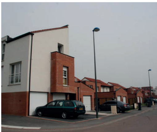
Photo 5, Habitat de type maisons individuelles construites suite à la rénovation conduite par l'ANRU Source: ANRU. Photo 6: Vue aérienne du quartier ou l'on constate que les garages ont été transformés en habitat des des espaces de stockage proposés à l'arrière des jardins. Source: Bazar Urbain
