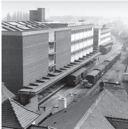
Photo 1 et 2: Construction et fonctionnement de la Cave à Vin, appareil productif faisant la fierté de l'entreprise COOP. Source: P. Wendling
