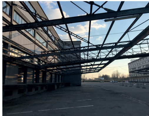
Photo 2 et 3: Auvents conservés de la Cave à Vin et Bassin du commerce tout proche.
