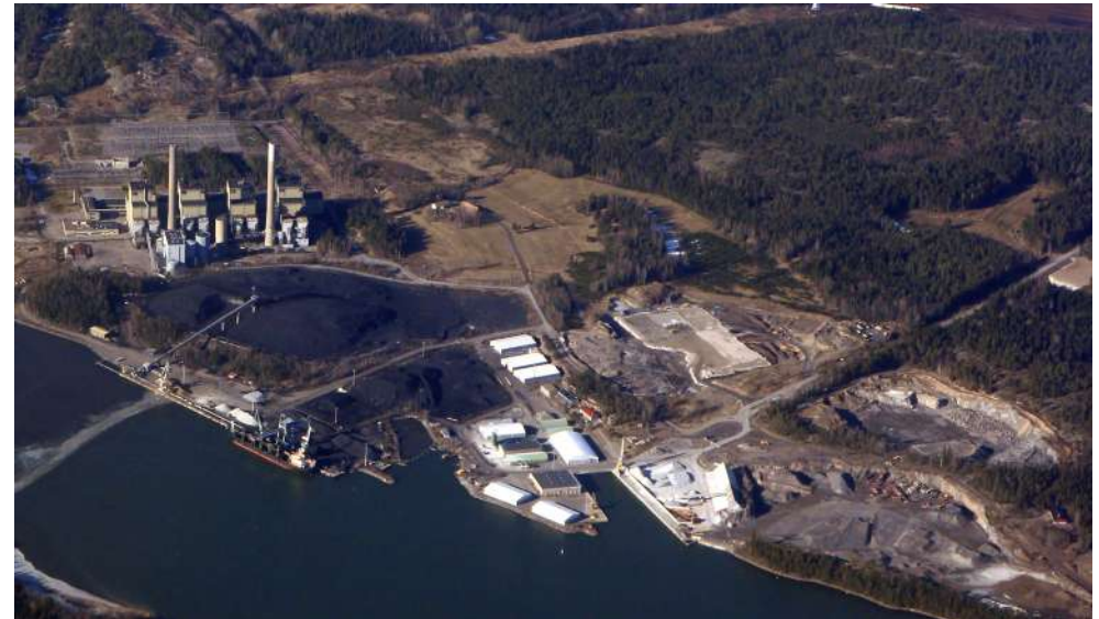
Différentes vues aériennes du site du Projet 2 dans son état actuel, incluant à l'Ouest, l'ancienne centrale à charbon et à l'Ouest les sites d'extractions des carrières et le port en eaux profondes Sources : Confidentielles
