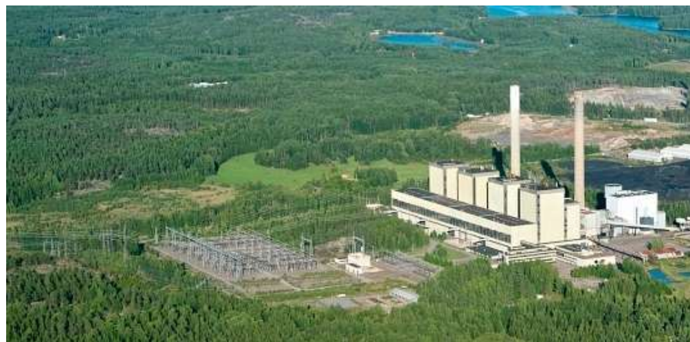
Les installations électriques de la centrale prennent une place importante dans le paysage Sources : Confidentielles
