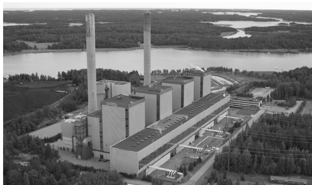
La centrale thermique à l'Ovest est un poids de taille dans l'aspect visuel et environnemental de la friche Sources : Confidentielles
