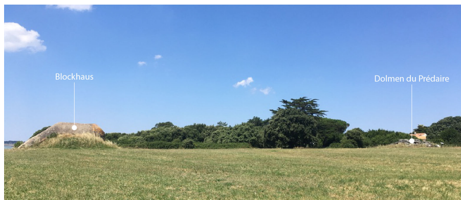
Figure 5 Dolmen et blockhaus à la Bernerie-en-Retz, source : Artiguenave, 2018
