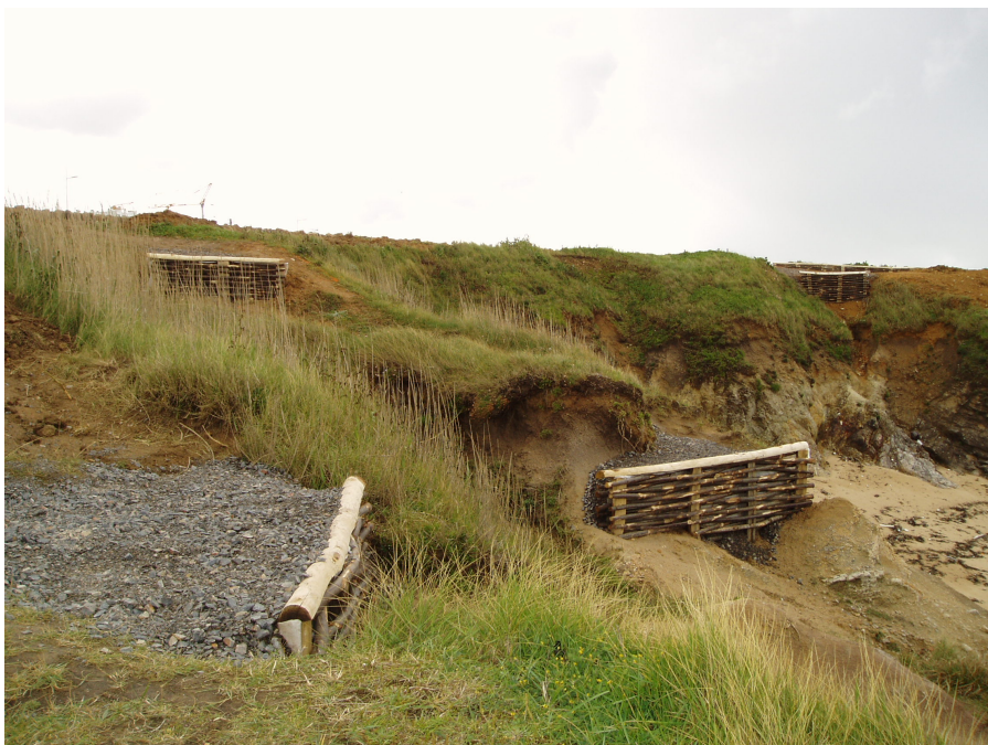
Figure 22 Facines sur le projet de restauration du littoral du Château d'Olonne par Phytolab, source : Phytolab , consulté en 2018
