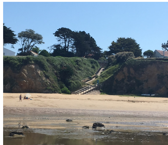
Figure 23 Escalier sur une falaise donnant accès au rivage entre La Bernerie et Pornic, source : Artiguenave, 2018
