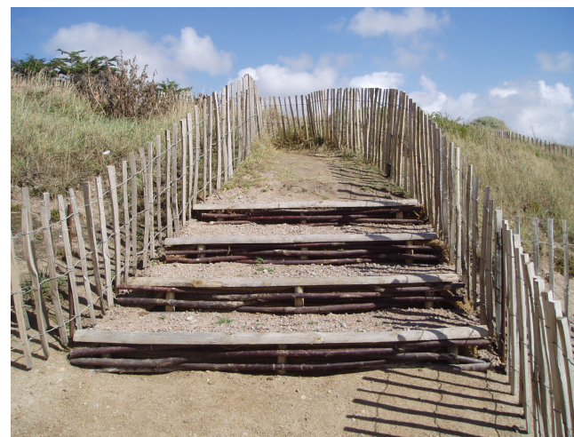
Figure 24 Escalier avec contremarche en fascine sur le littoral de Préfaillies aménagé par Phytolab, source : Phytolab, consulté en 2018
