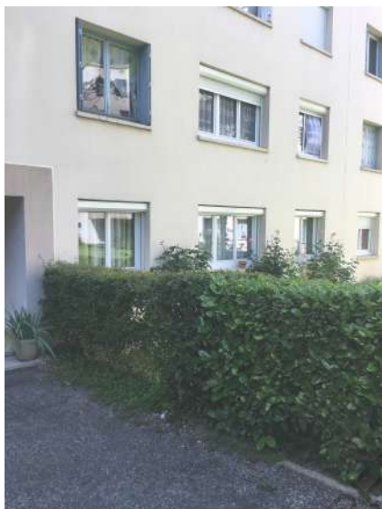
Accès au hall d'entrée, depuis le jardin.
