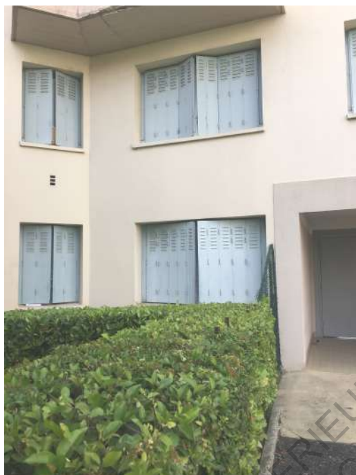
Volets fermés du bâtiment A5.
