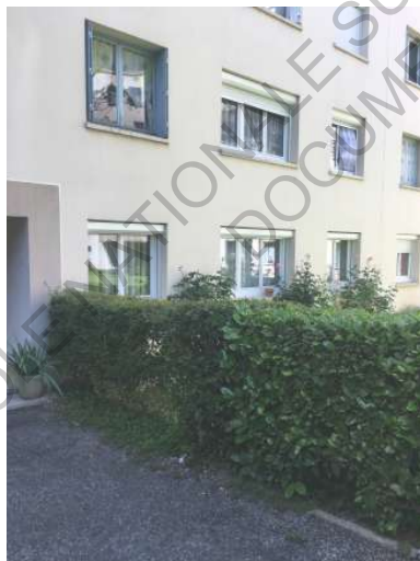
Accès au hall d'entrée depuis le jardin.
