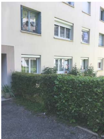
Accès au hall d'entrée, depuis le jardin.
