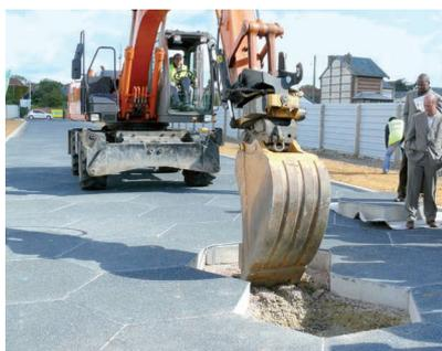
Fig.13 - Intervention sur un réseau sous la CUD – Source : (Cimbéton, 2008)
