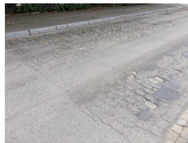
Fig.24 - Photos des pavés recouverts d'asphalte à Coronmeuse - Source : Tanguy Sorre, 14 Mai 2018
