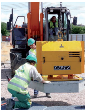
Fig.12 - Levage des dalles effectué à l'aide d'un engin de chantier muni d'un système de ventouse – Source : (Cimbéton, 2008)
