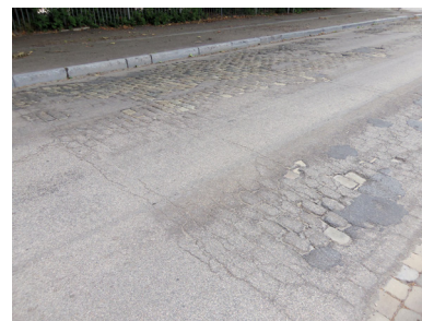
Fig.24 - Photos des pavés recouverts d'asphalte à Coronmeuse - Source : Tanguy Sorre, 14 Mai 2018
