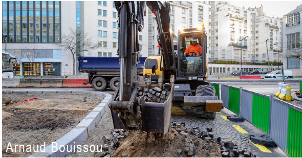
Opération de dépavage : intervention de la pelle mécanique
