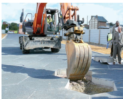
Fig.13 - Intervention sur un réseau sous la CUD – Source : (Cimbéton, 2008)
