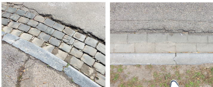
Fig.23 - Photos des fils d'eau en pavés de différentes natures à Coronmeuse - Source : Tanguy Sorre, 14 Mai 2018
