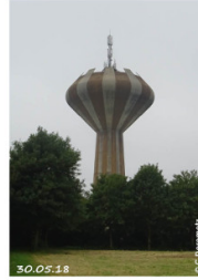
Le château d'eau, en forme de tulipe, point de repère du paysage : à remettre en valeur, au vue de sa visibilité dans le site.
