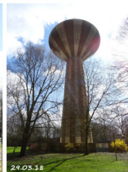
Au pied du château d'eau, rue de Fouquières.
