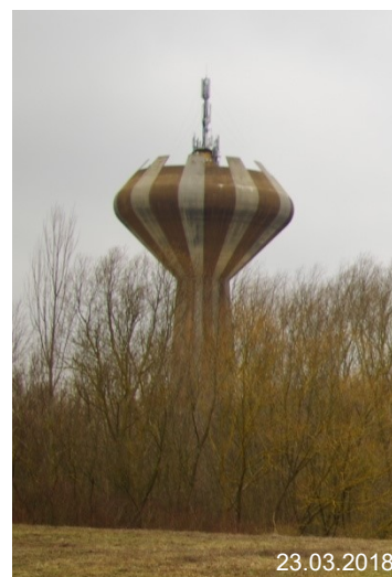
Figure 29 : Le château de Harnes, point de repère dans le paysage. (Deremetz, 2018)
