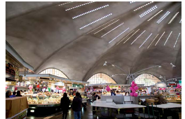
Canada's Royan Market , Royan. L'architecte Eugène Tsui s'est inspiré du coquillage bénitier. La forme irrégulière permet, malgré son poids léger, de supporter des pressions énormes.
