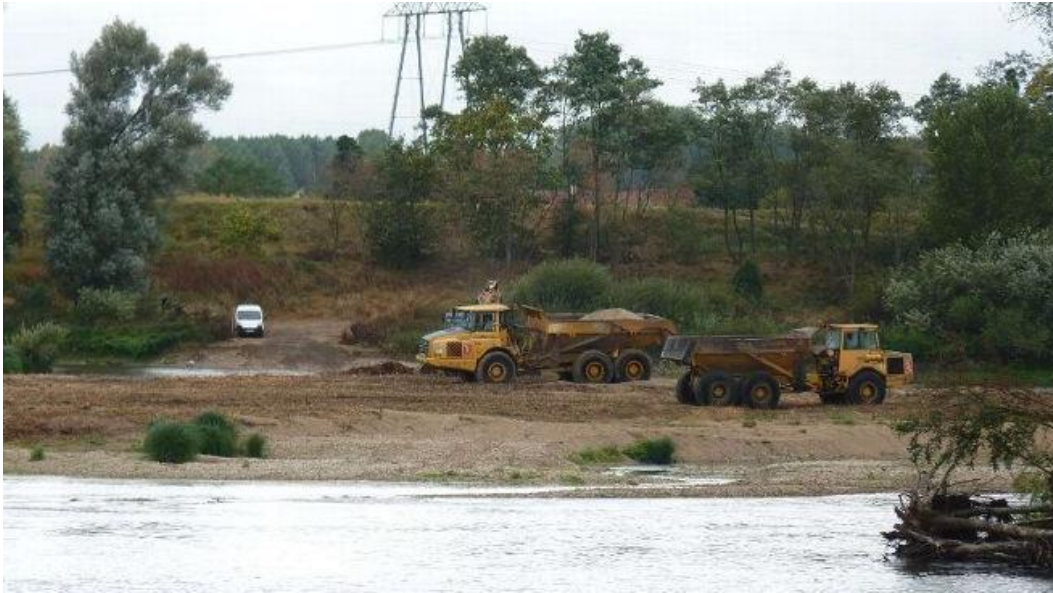
Figure 20 : Travaux d'arasement de l'îlot C vus depuis le coteau de Saint-Ay, le 21 septembre 2012 ©Christian Fer, La République du Centre 2012, https://www.larep.fr/saint-ay/2012/09/21/des-travaux-en-cours-sur-lile-de-mareau_1273452.html (Consulté le 18 Avril 2018)
