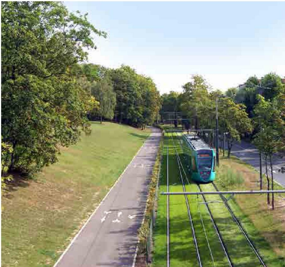
Tramway avenue Eisenhower à Reims (source Stéphane Delavallade)
