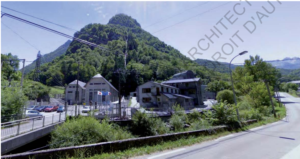
Figure 67. La centrale hydroélectrique d'Accous.
