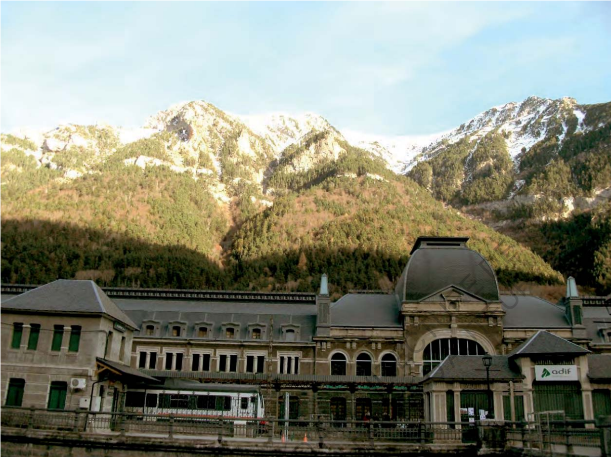
Figure 8. La gare monumentale de Canfranc.
