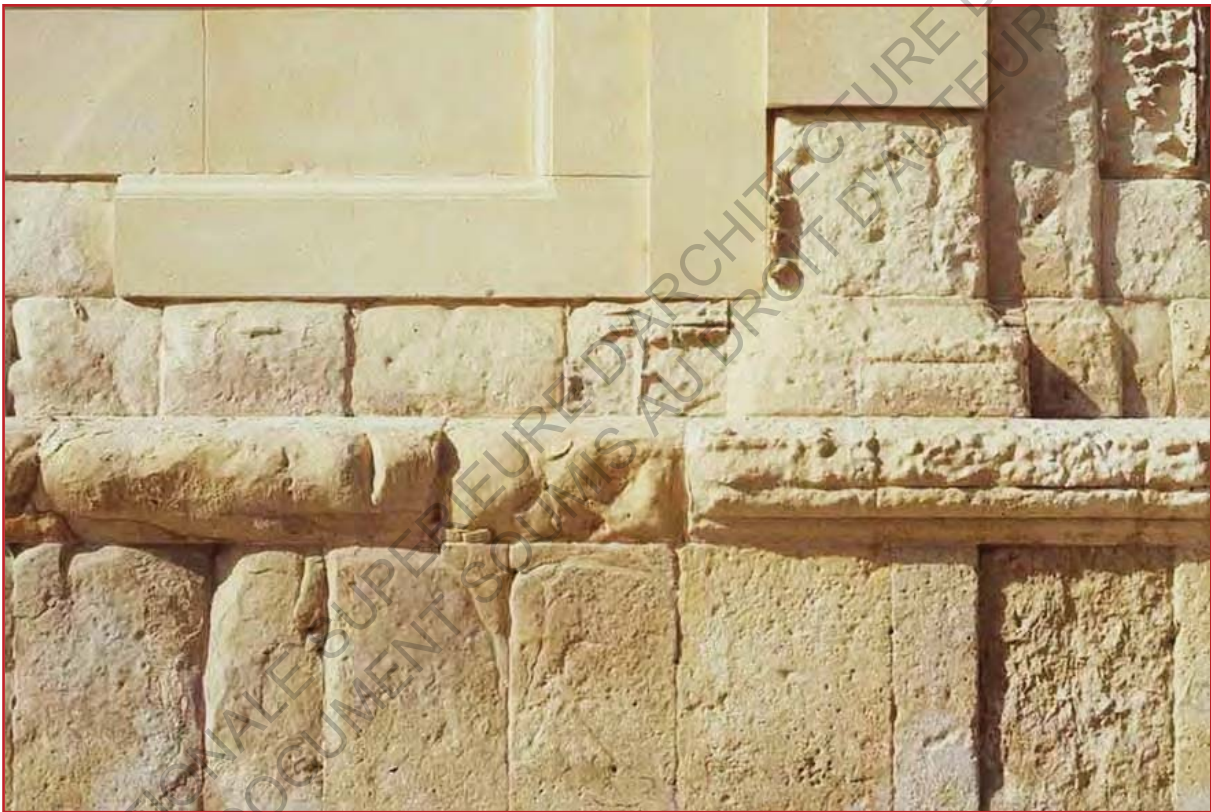
(1) Photo de détail de l'architecte Emanuele Fidone. Contraste de la pierre qui a subi les effets du temps avec la pierre neuve issues de la même carrière.
