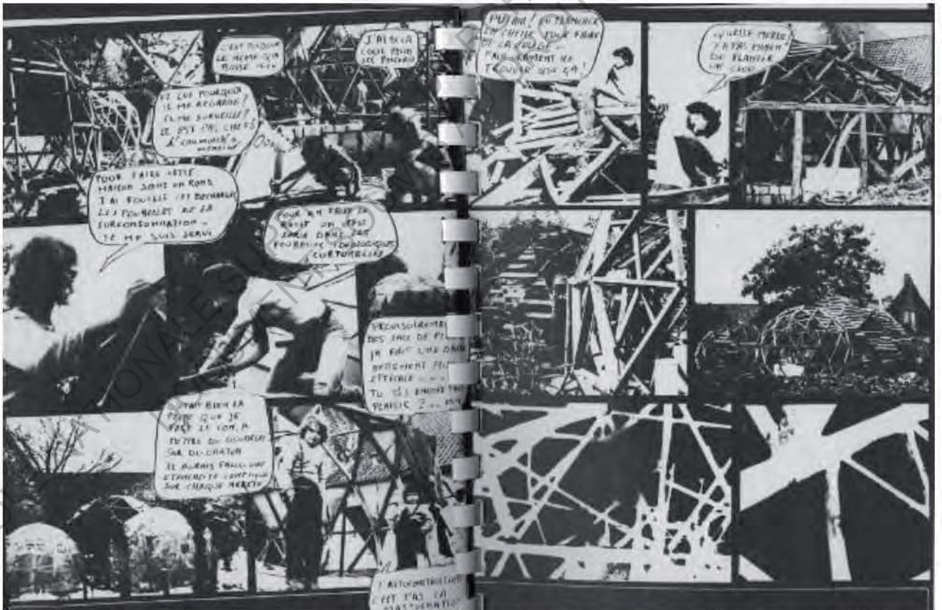
Figure 57 Page du TPFE Manuel d'Architecture, réalisé par Daniel Hermet en 1978. Ce passage, réalisé sous forme de bande dessinée, retrace les étapes de construction d'un zome par ses habitants, peut-être l'étudiant lui-même.
