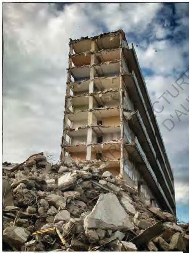
5 Démolition d'une barre à Empalot (© Pascal David)
