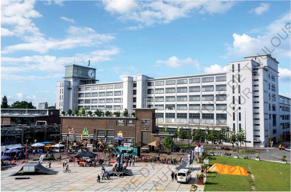
Figure 47 : Photo du Klokgebouw (bâtiment blanc)
