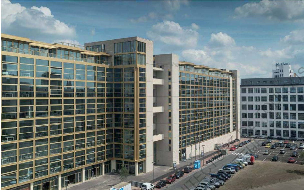
Figure 60 : Photo de l'ancien département lumière Philips transformé en complexe résidentiel (après travaux)
