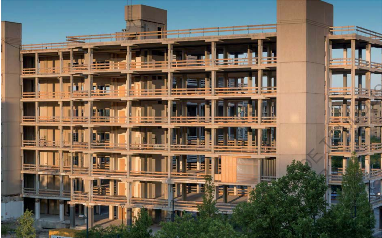
Figure 58 : Photo de l'ancien département lumière Philips transformé en complexe résidentiel (pendant travaux)
