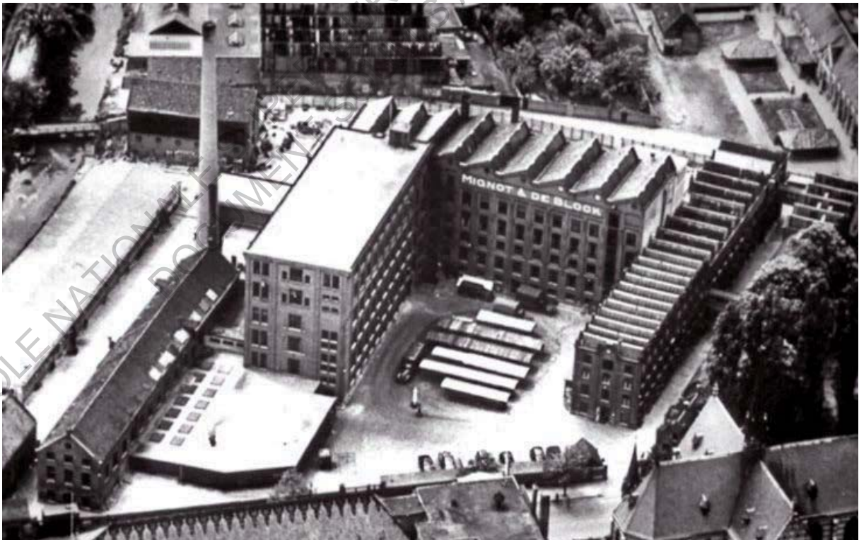
Figure 5 : Photo des usines Mignot & De Block
