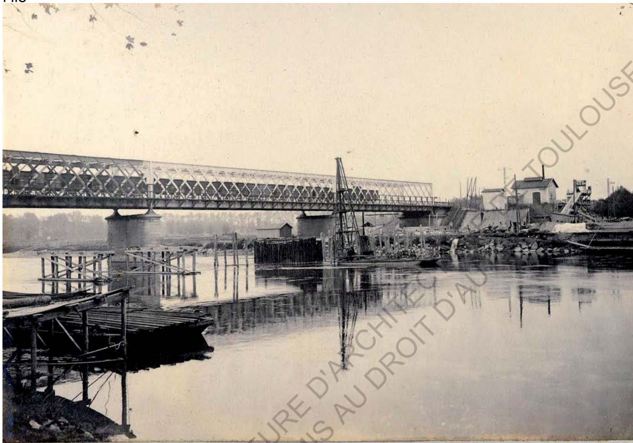
Photos site chimique Toulousain milieu de XX e siècle, passerelle reliant la rive gauche à l'île
