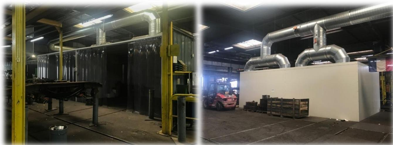
**Figure 21 : Cabine Arc - Air Bogies en cours d'installation**
