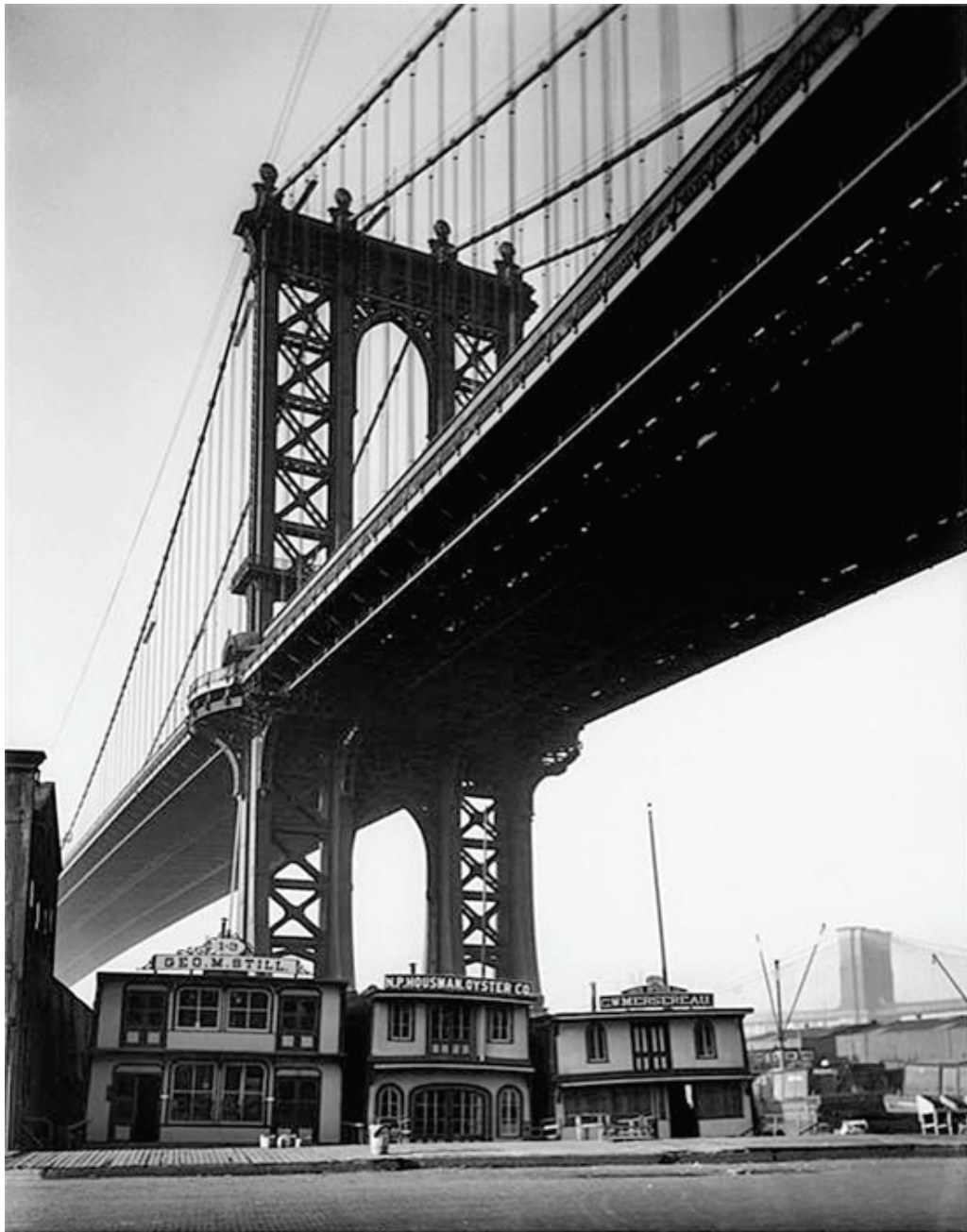
New-York, Manhattan Bridge, vers 1930
