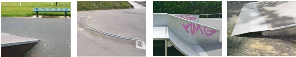
Figure 12 : Des erreurs de conception observées sur des Skatepark : plan incliné menant à un obstacle, rail pouvant générer des blessures par coincement, plan trop raide pour être utilisable ou encore bavette de transition entre sol et plan incliné qui se décolle. (EuroSIMA, 2011)
