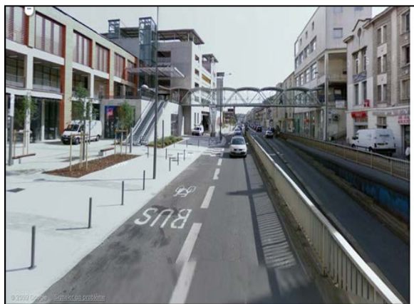
Figure 12: Voie bus réservée, gare de Poitiers.
