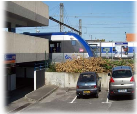
Figure 21: Parking Effia - Gare d'Angoulême (Source : photo de l'auteur)
