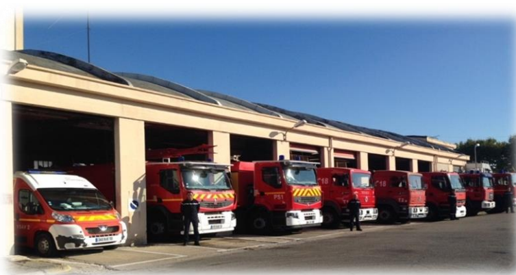
Figure 8 : Photo de la caserne de pompier interne
