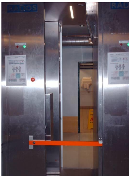
Figure 17 : Portique de sortie de zone contrôlée C2
