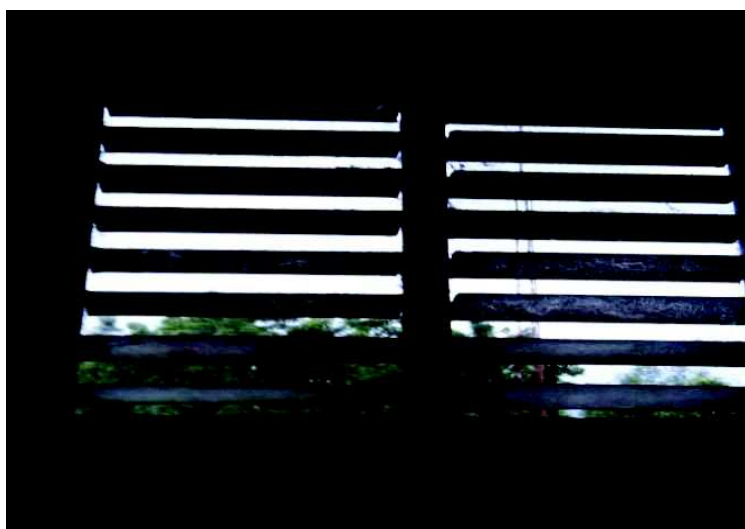
Figure 10 : Fenêtre dans l'un des bâtiments du CHPK et ses nacos recouverts de poussière
