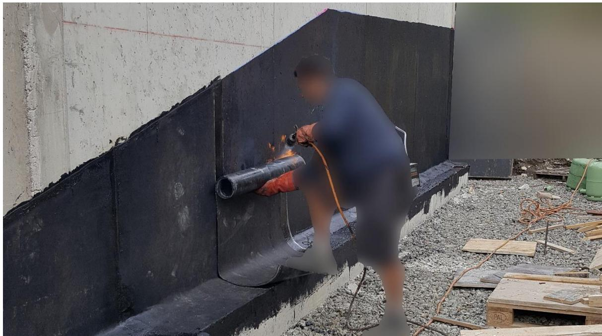
**Figure 17 - Soudage au chalumeau sur toute la surface de la feuille (relevés toiture-terrasse)**
