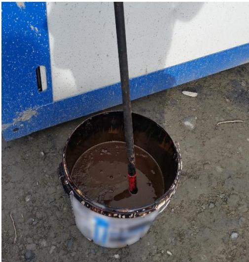
Utilisés comme primaire d'accrochage, ils sont étalés sur support sec à la raclette, au rouleau, pinceau ou à la brosse (figure 9) et permettent aux feuilles bitumineuses d'adhérer à la plupart des supports sur lesquels elles sont appliquées [Siplast 2018, CSFE - FFB 2009].
