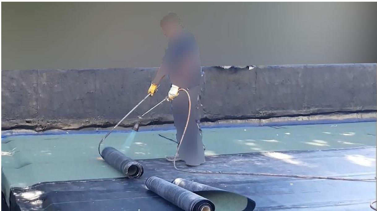
**Figure 15 - Soudage au chalumeau exclusivement au niveau des zones de recouvrement des feuilles (1<sup>ère</sup> couche, partie courante toiture-terrasse)**
