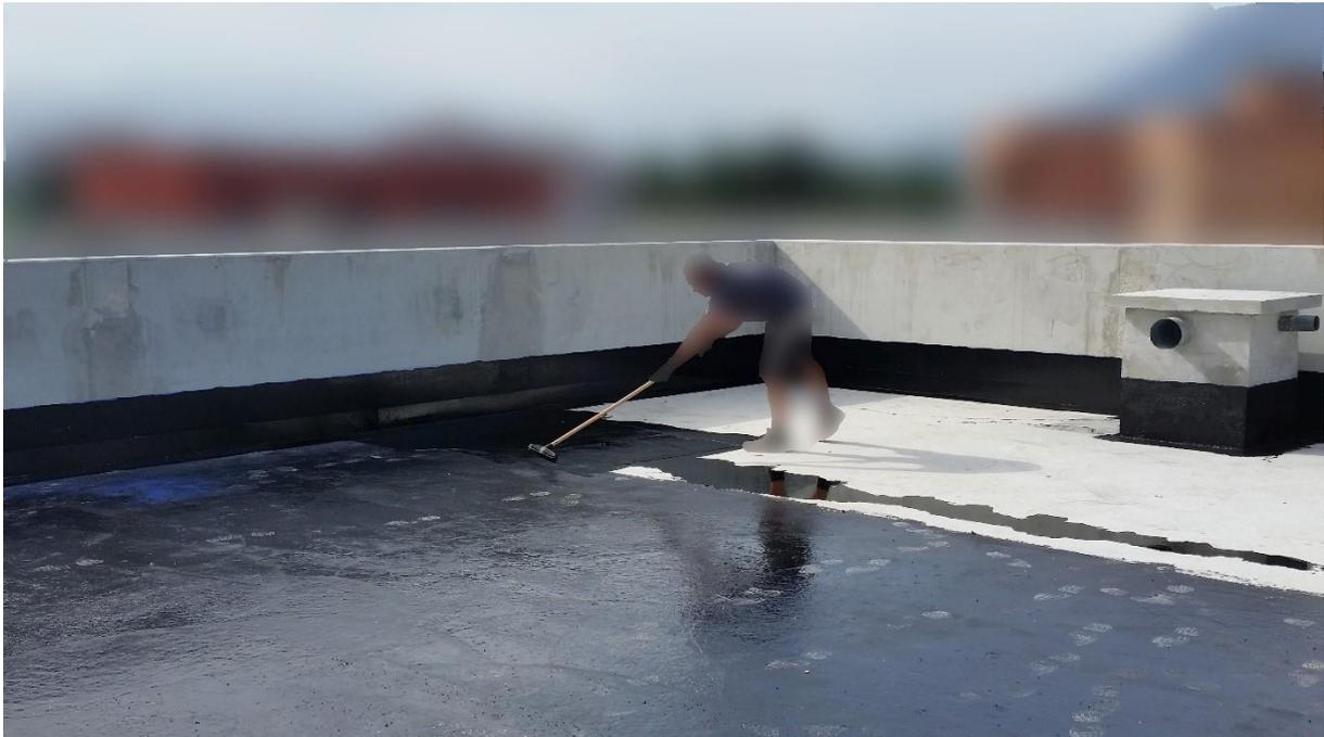
Actuellement, les enduits d'imprégnation à froid les plus répandus sont à base de bitumes modifiés. Par le passé, ils pouvaient être à base de bitumes oxydés.
