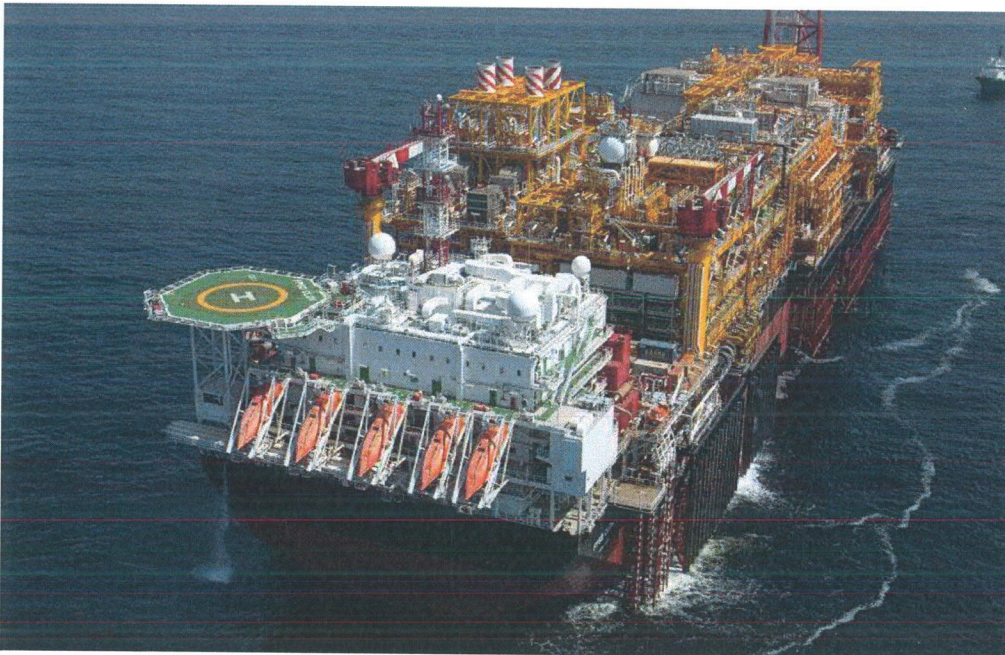
Barge FPSO Guirassol au large de l'Angola (Source : Total - © GONZALEZ THIERRY)
