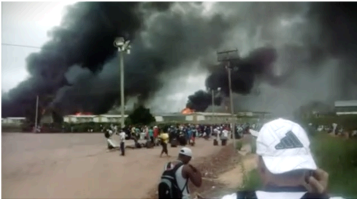
Image 21: Départ de feu dans les hébergements ouvriers du chantier de Jirau. Source : Caio Cavechini, Carlos Juliano Barros, “Jaci – Sete Pecados De Uma Obra Amazônica”, Repórter Brasil, 2015, 102 minutes.
