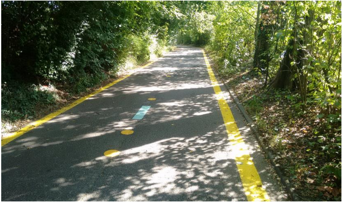
Section courante sur un tronçon arboré de la piste cyclable des Jeux Olympiques, mise au standard chronovélo (ligne 2).
