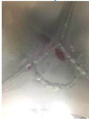
Figure 50: Photo d'un angle du mélangeur avec résidu de poudre
