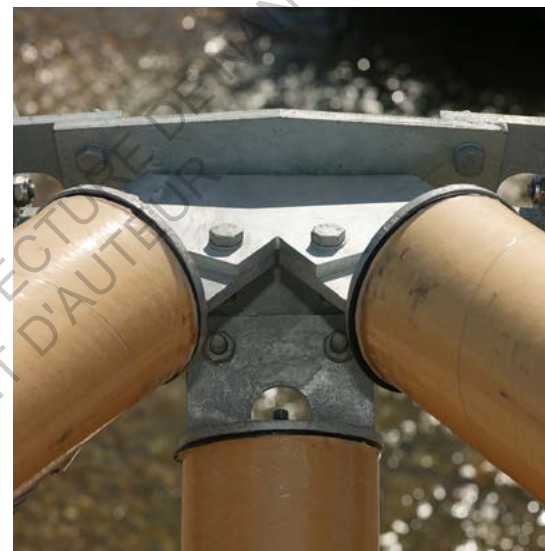
Détail d'assemblage en métal, pont de papier
