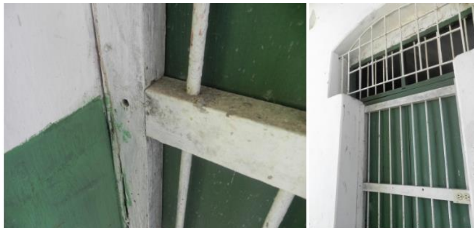
Illustration 9 : Lorsque le Musée Communautaire de San Jacinto fut créé en 1984, la collection de 5 pièces archéologiques était disposée sur une étagère fixée sur cette porte, au fond du patio central. On peut encore y voir les perforations qui permettaient de faire tenir l'étagère.
