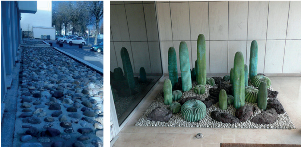
Fig.11 Exemples de mobilier répulsif : des galets scellés dans du béton et des cactus pour souhaiter la bienvenue aux résidents... À gauche : Crédit photo Dijon © Radio France - Thomas Nougailon, à droite : Crédit Streetpress
