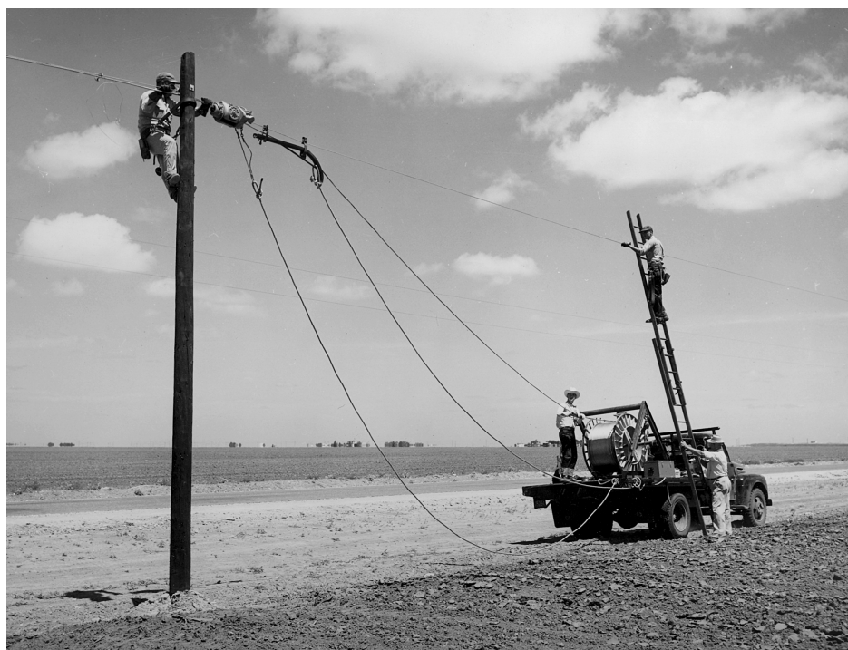
Figure 5 : Mise en place du réseau électrique en Alpes-de-Haute-Provence Source : Syndicat d'Énergie des Alpes-de-Haute-Provence – SDE04
