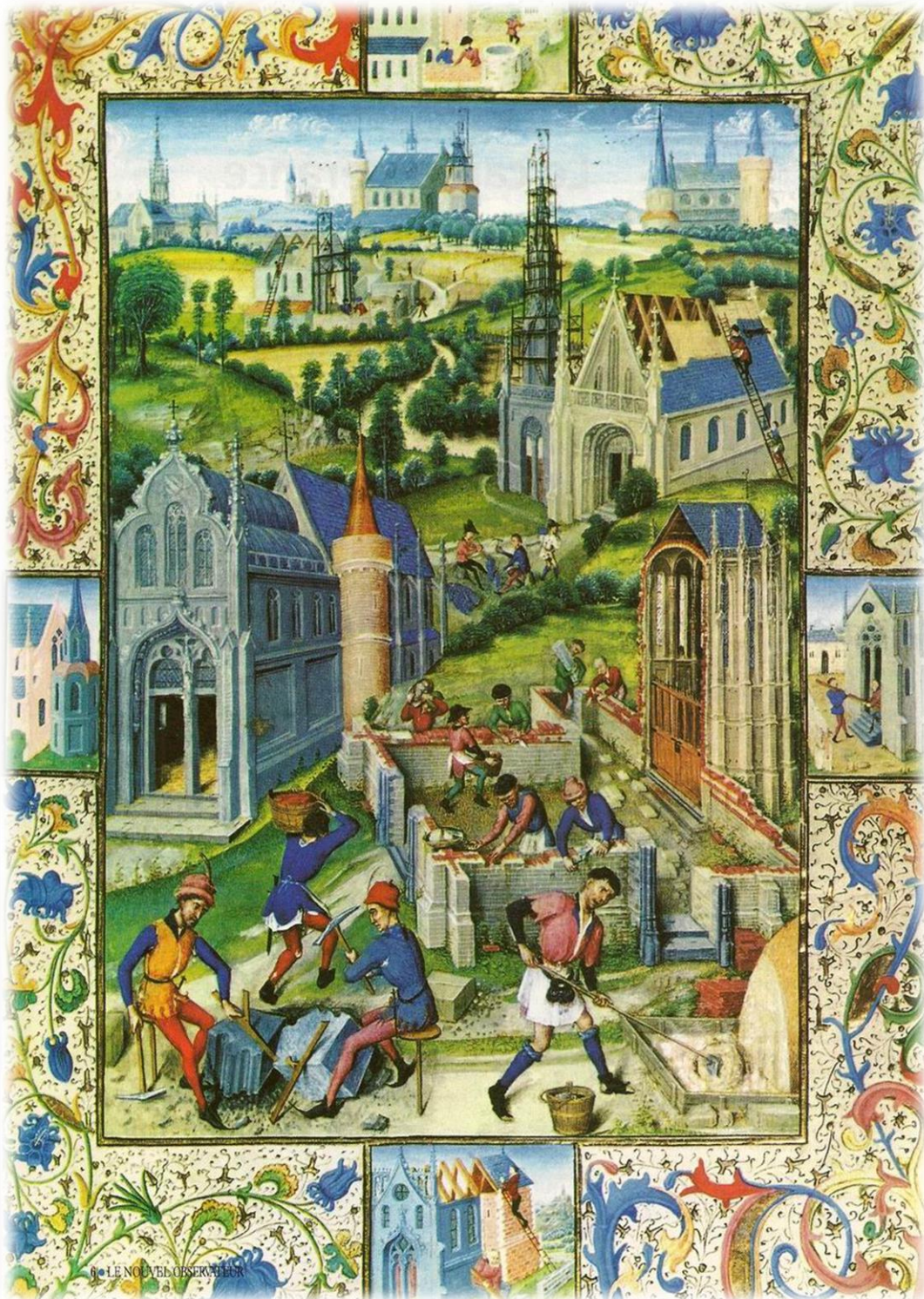
Miniature du XIII e siècle représentant la construction d'une église à Saint-Denis
