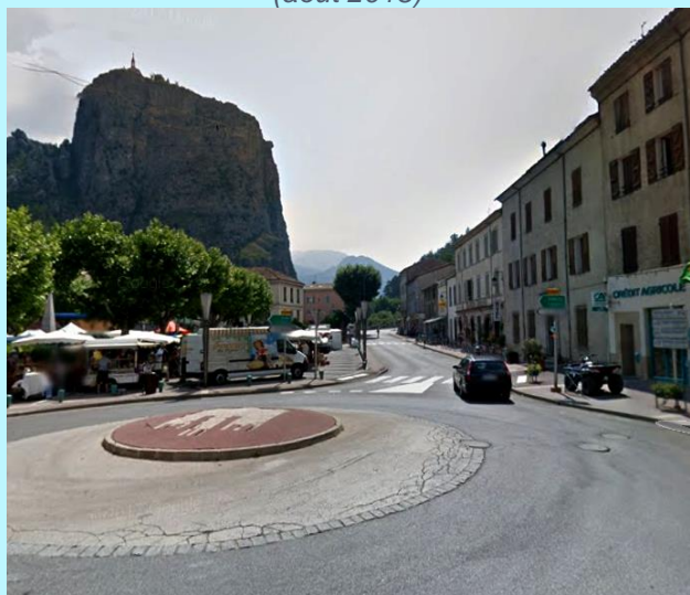
Figure 38 : Vue du Roc depuis le Bourg (août 2018)
