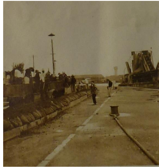
(Figure 19 : Digue quai de France ) 2
