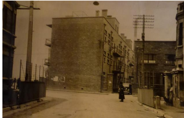
(Figure 13 : Porte rue Gaston Khan ) 2
