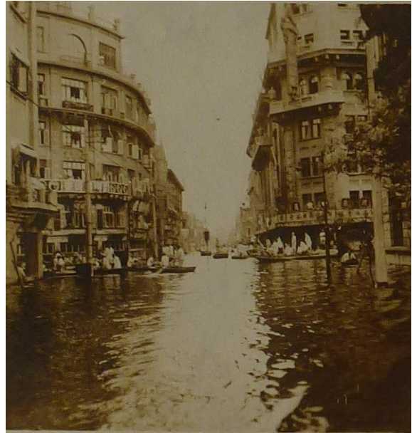
(Figure 28 : Rue Maréchal Foch ) 3
