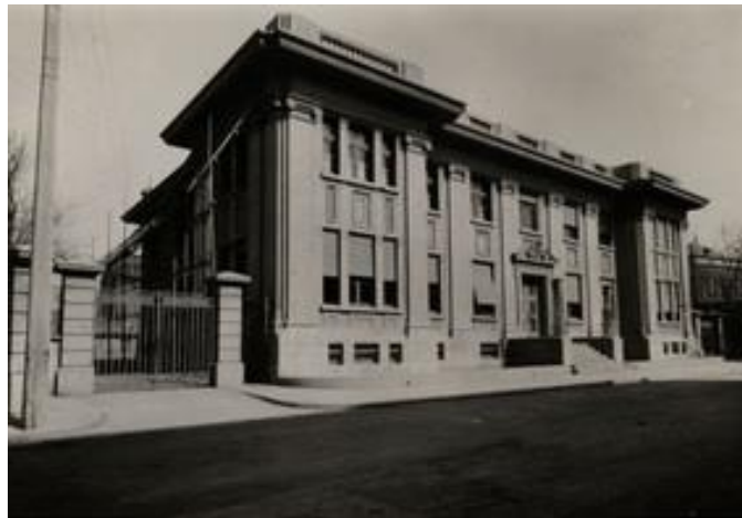
(Figure 4 : Consulat de France de Tianjin ) 1
