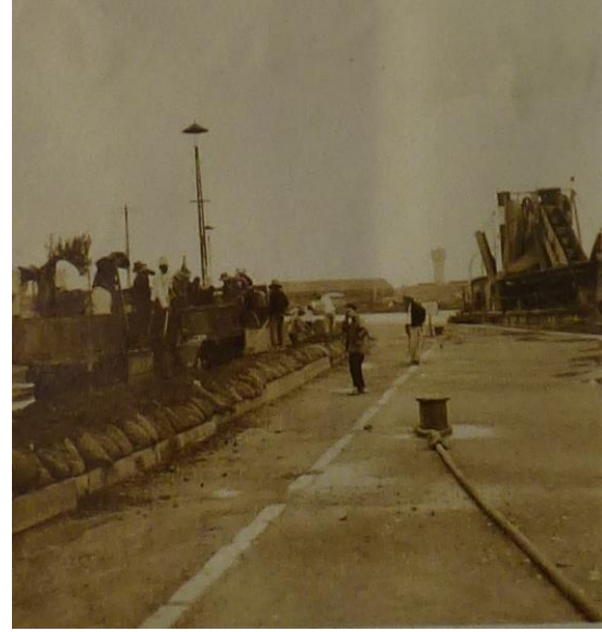
(Figure 19 : Digue quai de France ) 2
