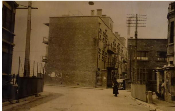
(Figure 13 : Porte rue Gaston Khan ) 2
