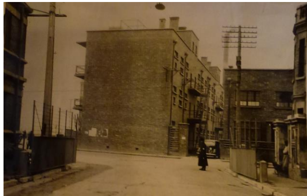
(Figure 13 : Porte rue Gaston Khan ) 2
