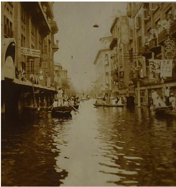
(Figure 25 : Rue Maréchal Foch ) 3
