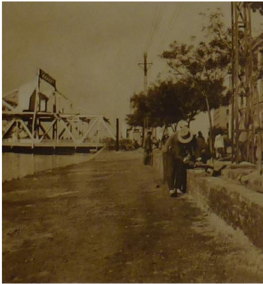
(Figure 18 : Digue quai A. Boppe ) 1
