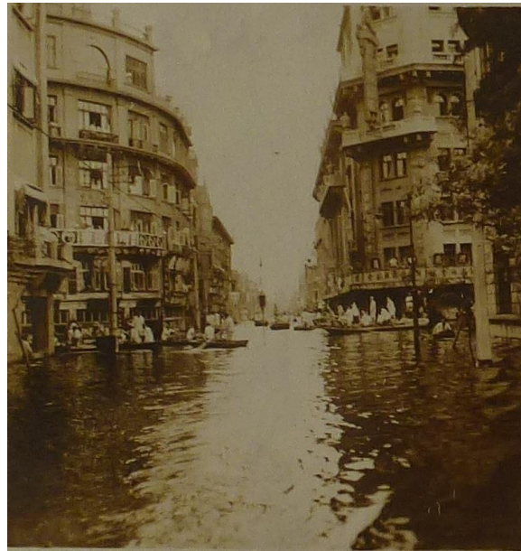
(Figure 28 : Rue Maréchal Foch ) 3
