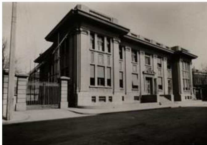
(Figure 4 : Consulat de France de Tianjin ) 1
