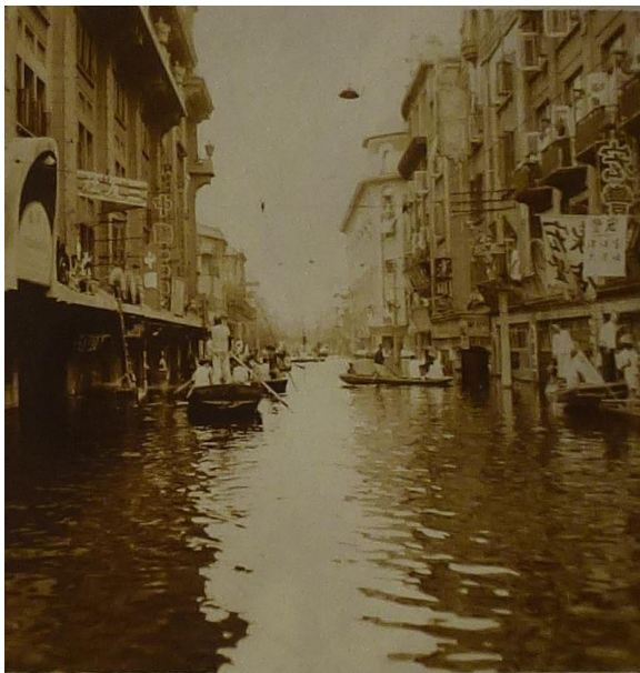
(Figure 25 : Rue Maréchal Foch ) 3
