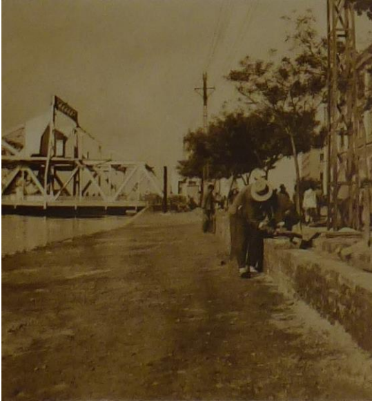
(Figure 18 : Digue quai A. Boppe ) 1
