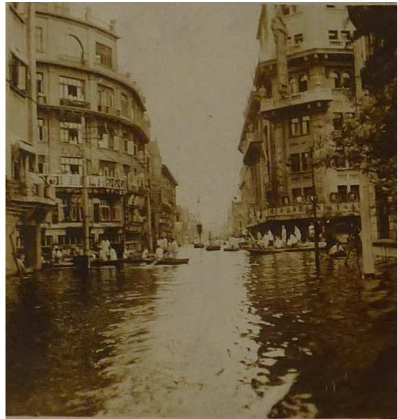
(Figure 28 : Rue Maréchal Foch ) 3
