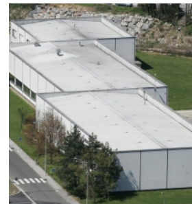
Figure 29 : Usine de Mazamet
