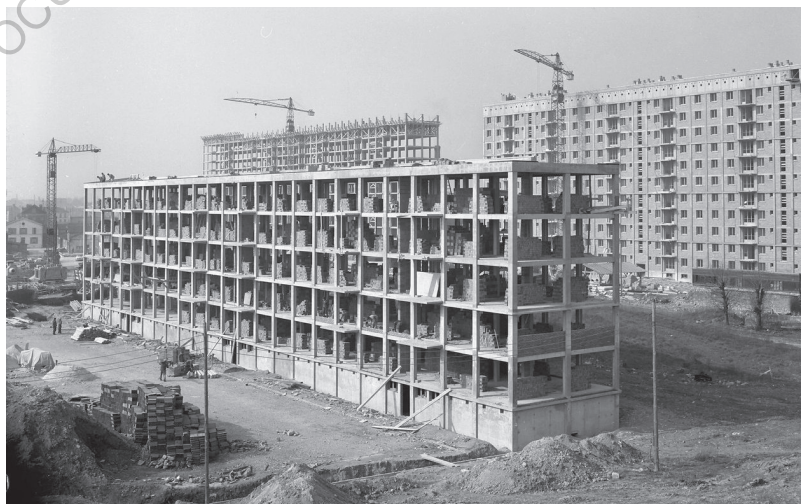
fig. 2 construction du Grand ensemble de Gentilly en 1958
