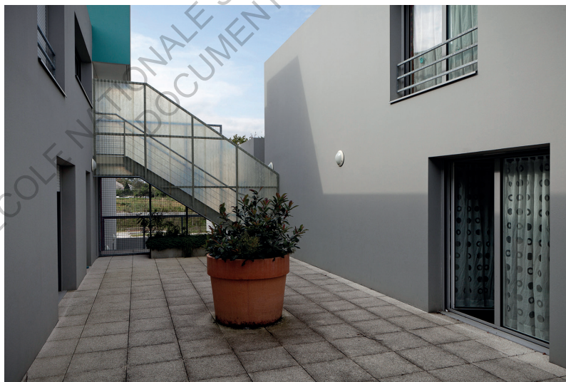
fig. 29 photo d'une terrasse commune partagée entre 2 à 3 logements.
