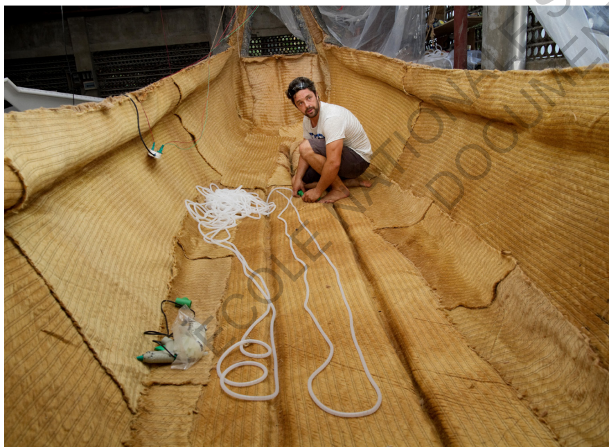
Photo : Gold of Bengal. Construction en jute du Gold of Bengal
