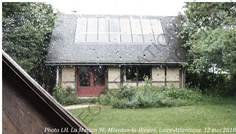
L'Habiterre en construction, Moisdon-la-Rivière, Loire-Atlantique
