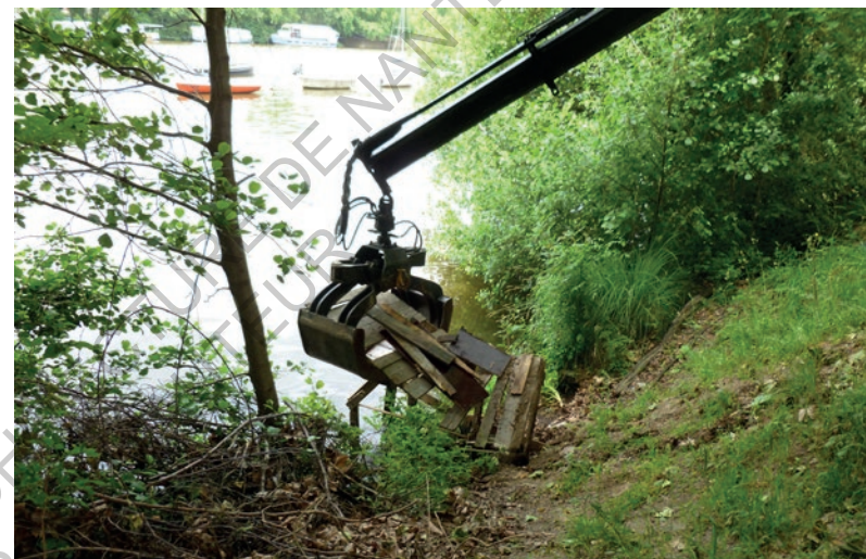
Démolition du ponton en dix minutes, le 28 mai 2018
