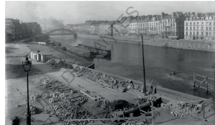
Stockage de matériaux et bateau-bain amarré au quai de l'île Gloriette (Source : Nantes, Histoire d'eau, Stéphane Pajot)
