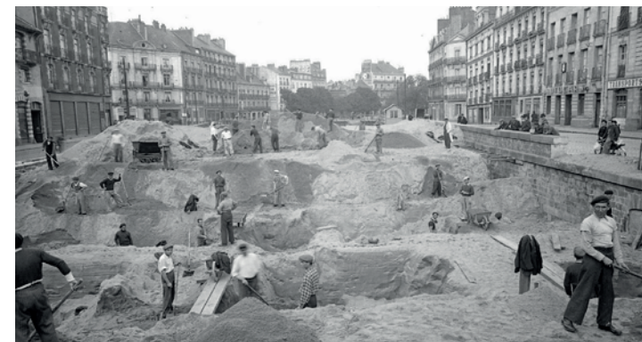
Travaux de comblement de l'Erdre vus du pont de l'hotel de ville en octobre 1940 © Archives Nantes
