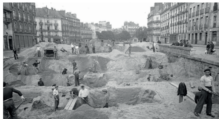
Travaux de comblement de l'Erdre vus du pont de l'hotel de ville en octobre 1940 © Archives Nantes
