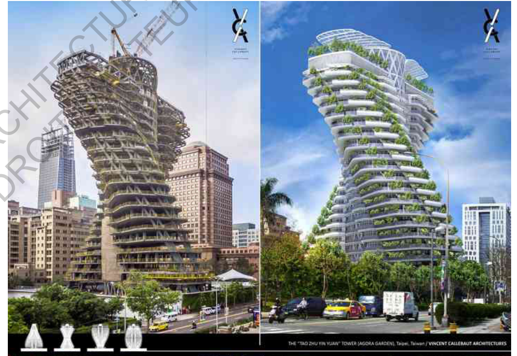
Tour absorbante de Taipei, en cours de construction © Vincent Callebaut Architectures
