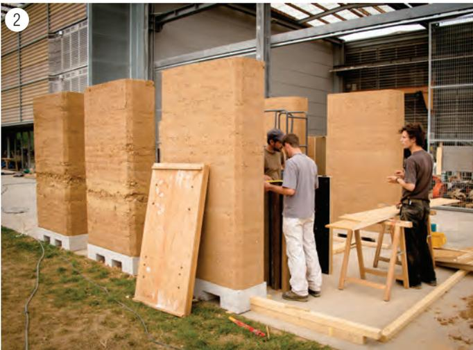
La conception de ce pavillon se voulait économique. Le choix des murs trumeau transportables s'est avéré judicieux à plusieurs titres. Architecturalement, il permet de jouer avec une trame régulière et de pouvoir choisir et changer la dimension des fenêtres facilement. De plus, cela évite l'insertion d'ouvertures dans le pisé et donc la mise en œuvre d'un linteau en bois ou en béton.
