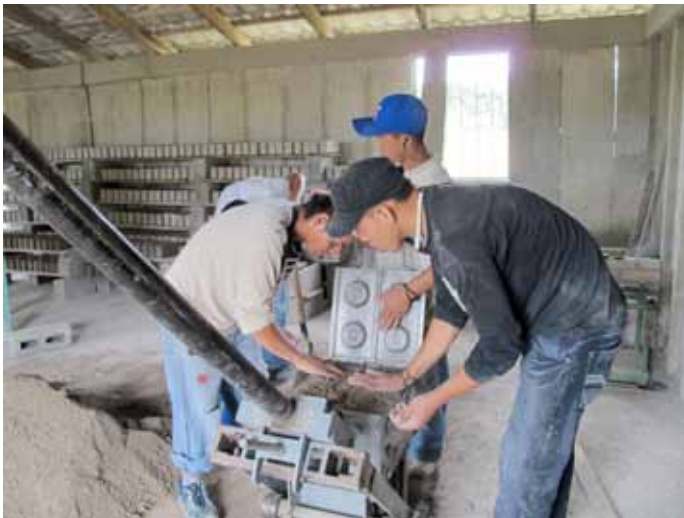
Figure 78- Remplissage de la presse avec le mélange de terre stabilisée au ciment (Source : photographie personnelle)
