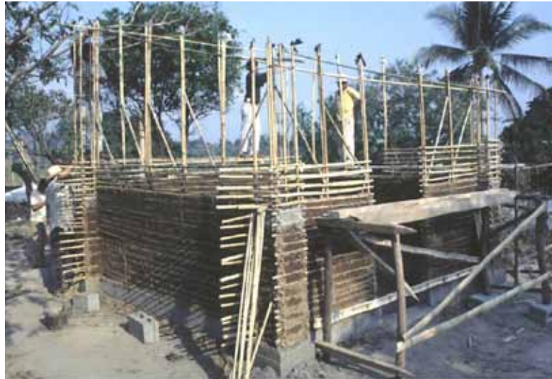
Figure 180- Chantier d'habitat de Bahareque « Cerén Reforzado » (Source : Document pédagogique CRATerre)
