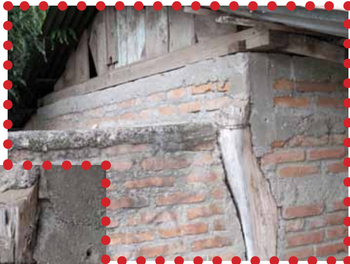
Figure 159- Assemblage douteux poteaux bois / poutre béton armé avec du fil barbelé. La continuité de la structure n'est pas assurée. Faiblesse de la jonction (Source : photographie personnelle)
