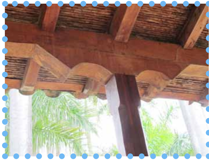
Figure 155- Tête de poteau spécifique: souplesse de la liaison poteau - poutres offrant moins de contrainte mécanique ponctuelle, permettant un meilleur appui, tolérant les mouvements (Source : photographie personnelle)
