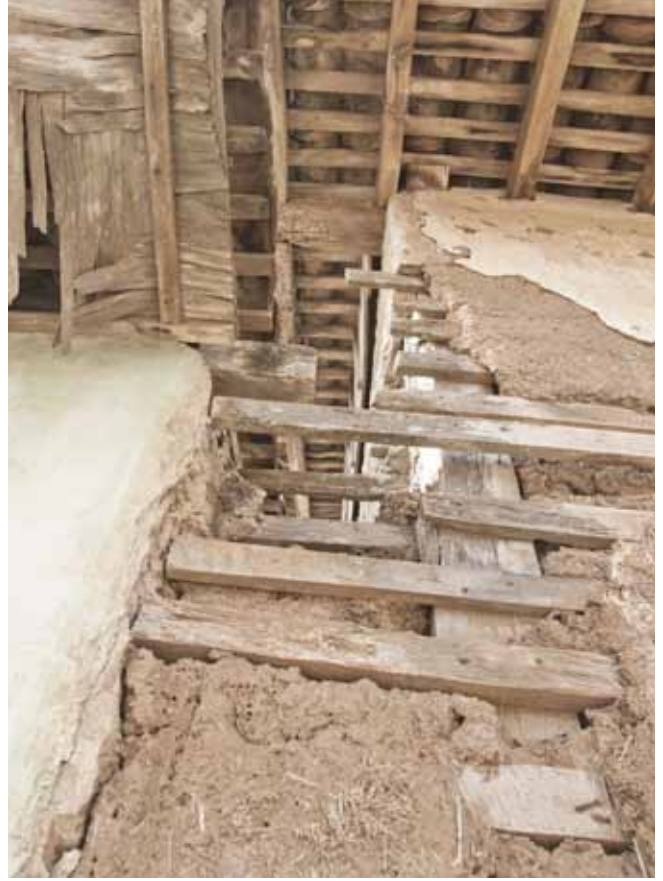
Figure 112- Maison en taquezal remplie de terre (Source : photographie personnelle)
