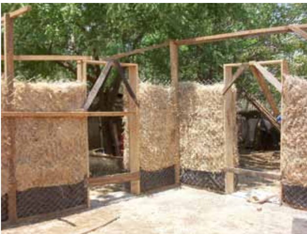
Figure 72- Vue de la coupure capillaire, de la structure et du remplissage (Source : Norman Padilla, ADIC)
