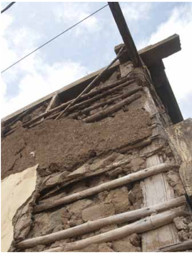
Figure 110- Maison en taquezal remplie de gravas (Source : photographie personnelle)
