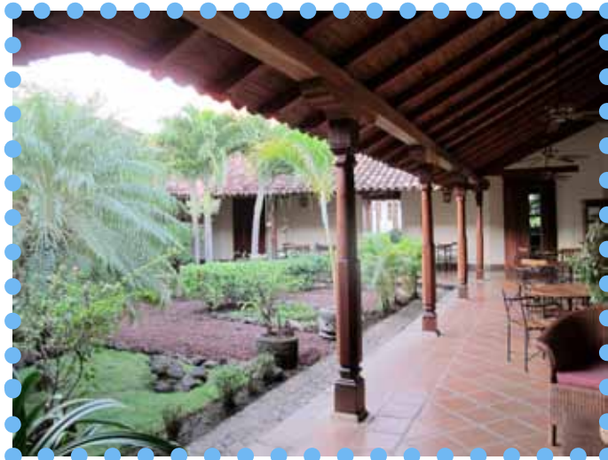
Figure 134- Hôtel El Patio del Malinche - structure porteuse de la toiture à caractère antisismique (source : photographie personnelle)
