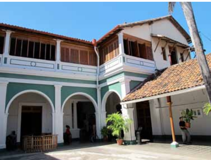
Figure 121- Casa de Los Tres Mundos (Granada) en adobe (RdC) et en taquezal (étage) (Source : photographie personnelle)
