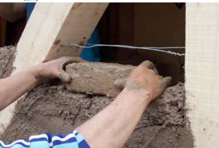
Figure 115- Taquezal : remplissage de la structure primaire avec des briques d'adobe (Source : www.culturconstructivas.blogspot.com)
