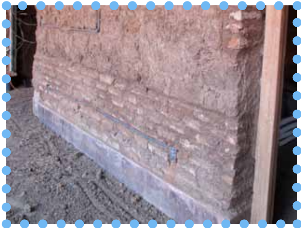
Figure 128- Haut soubassement en briques de terre cuite reposant sur de profonds murs de fondation en pierre (source : photographie personnelle)
