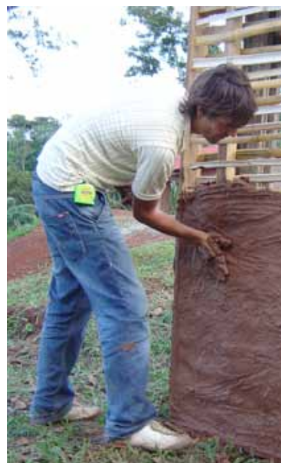
Figure 183- Garnissage des panneaux (Source : Arch. Dulce Maria Guillen)
