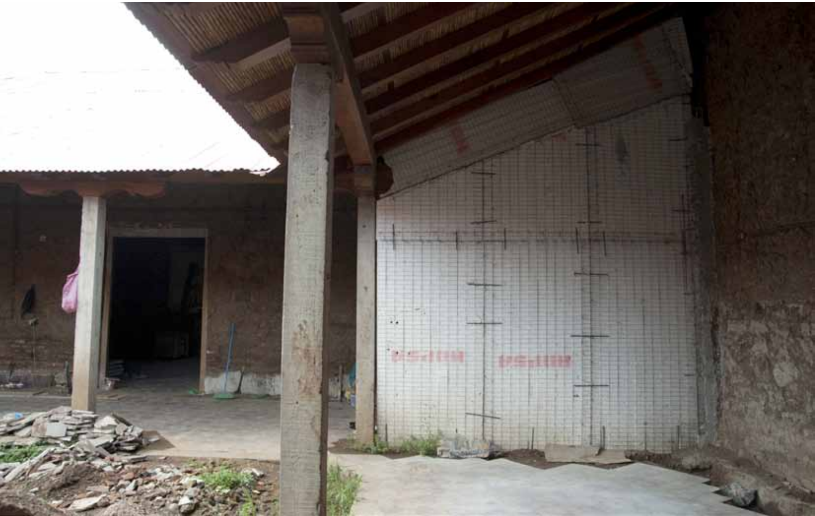
Figure 55- Exemple de réhabilitation en Electromalla d'une habitation traditionnelle en adobe (Source : photographie personnelle)
