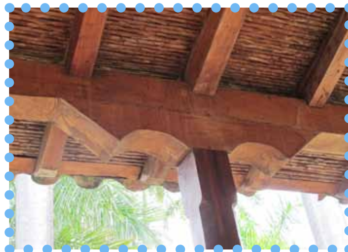
Figure 130- Tête de poteau spécifique: souplesse de la liaison poteau - poutres offrant moins de contrainte mécanique ponctuelle, permettant un meilleur appui, tolérant les mouvements (source : photographie personnelle)
