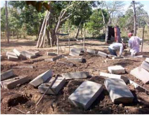
Figure 70- Préparation du site (Source : Norman Padilla, ADIC)
