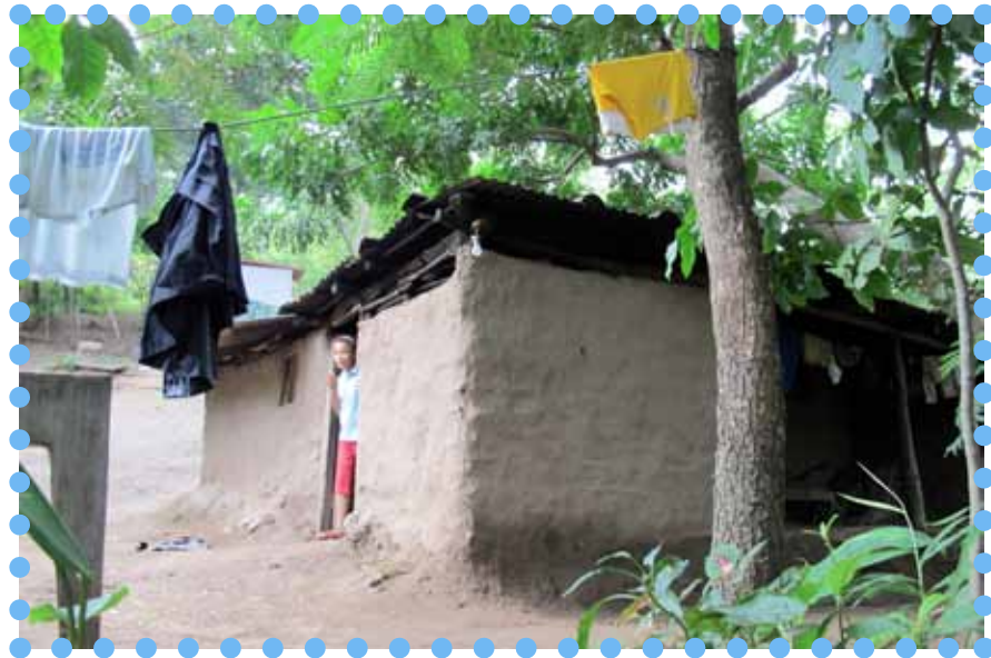
Figure 123- Habitation de Condega (Nueva Segovia) en taquezal albardeado (Source : photographie personnelle)
