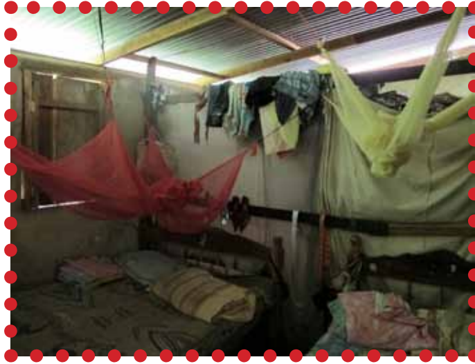
Figure 144- Couverture en zinc sans masse isolante en surface ou sous-face : fort rayonnement et convection dans l'habitation. Chaleur étouffante dès les premiers rayons du soleil (Source : photographie personnelle)
