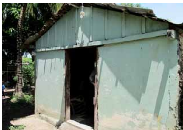
Figure 31- Habitation à Granada (Source : photographie personnelle)
