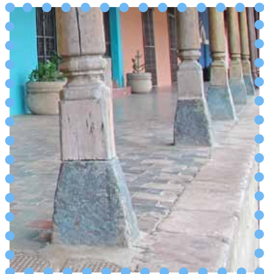
Figure 157- Pierre d'appuis (fondations) du poteau : déconnexion du sol (barrière capillaire, pose du poteau par tenon - mortaise, tolère les mouvements en cas de séisme (source : photographie personnelle)
