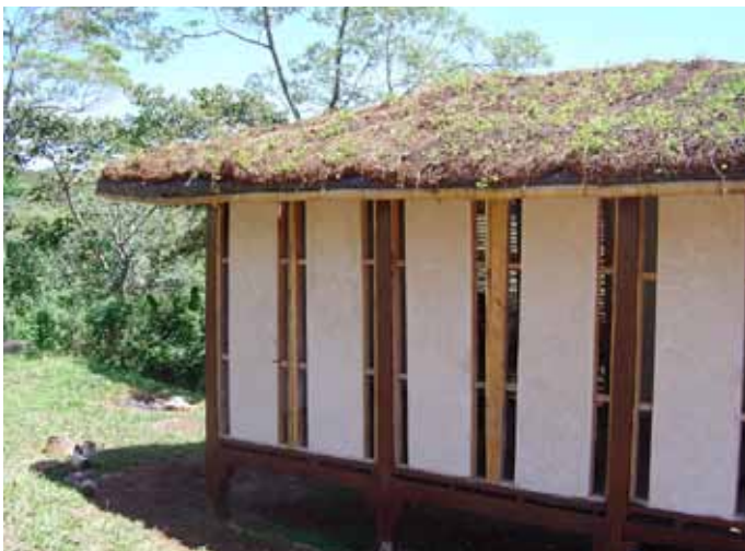
Figure 184- panneaux de taquezal albardeado garnis de terre et toiture végétalisée (Source: Arch. Dulce Maria Guillen)
