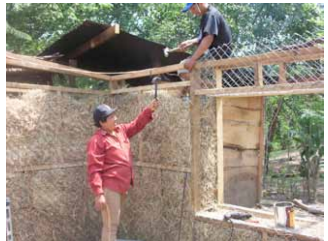
Figure 73- Pose de la maille métallique (Source : Norman Padilla, ADIC)
