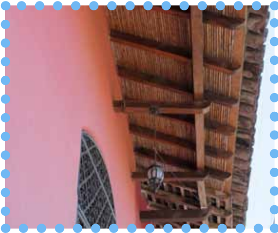
Figure 142- Toiture avec débords suffisants et dotées d'une sous-couche en canne (Source : photographie personnelle)
