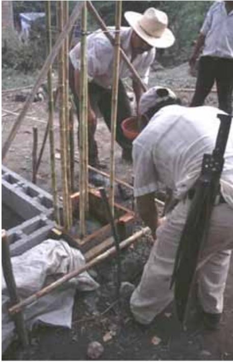
Figure 179- Préparation des fondations (Source : Document pédagogique CRATerre)
