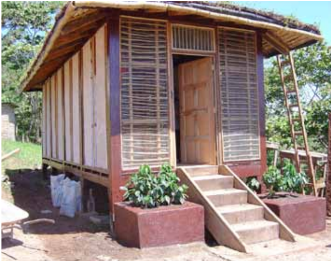
Figure 182- Vue de la façade d'entrée en taquezal albardeado : clissage bois / bambou (Source: Arch. Dulce Maria Guillen)
