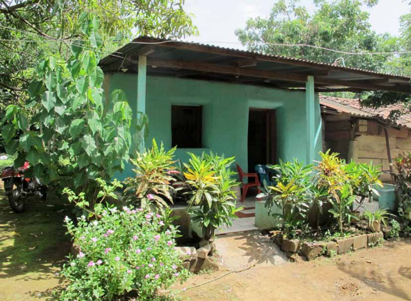
Figure 64- Nouvelle maison en paille, joutant l'ancienne demeure, faite de planches de bois, tôles et tuiles en terre cuite (Source : photographie personnelle)
