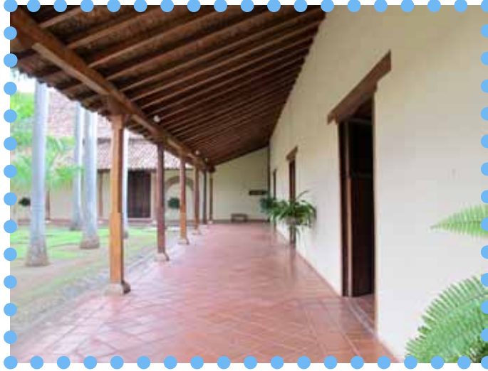
Figure 132- Patio du couvent San Francisco : résistance améliorée face aux cyclones, avancée de toiture protégeant les murs de la pluie (durabilité) et du soleil (confort), coeur intime du bâti (source : photographie personnelle)
