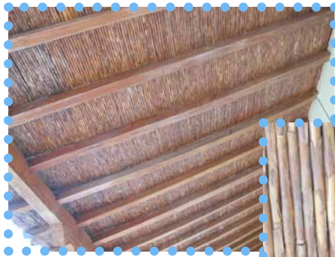
Figure 142- Toiture avec débords suffisants et dotées d'une sous-couche en canne (Source : photographie personnelle)
