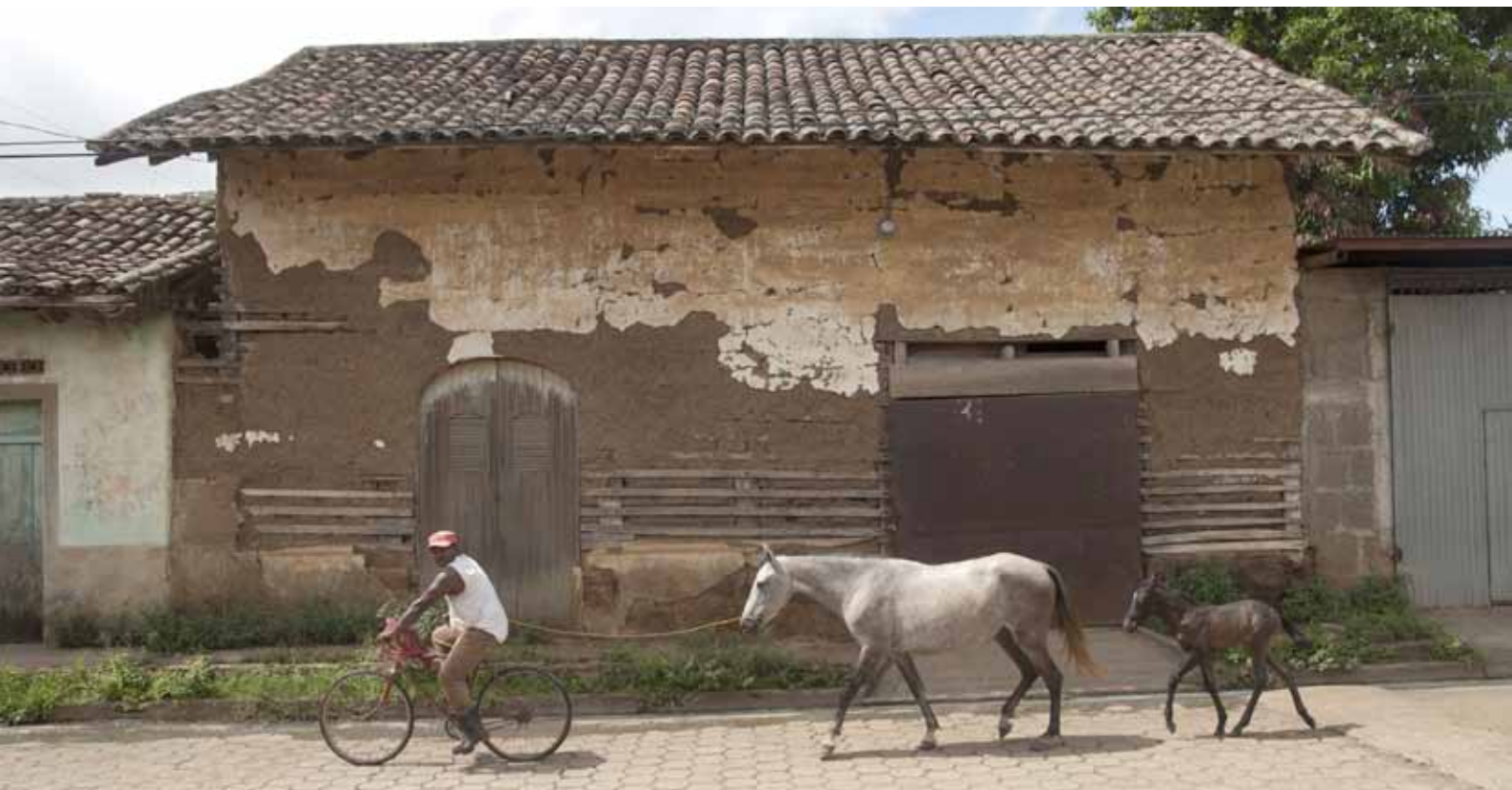
Figure 102- Habitation en taquezal du grand-père de Gema Johanna Castillo Talavera, dont la construction date d'au moins 75 ans. Cette maison a subit de nombreux séismes et sa structure demeure très bien conservée (Source : photographie personnelle)
