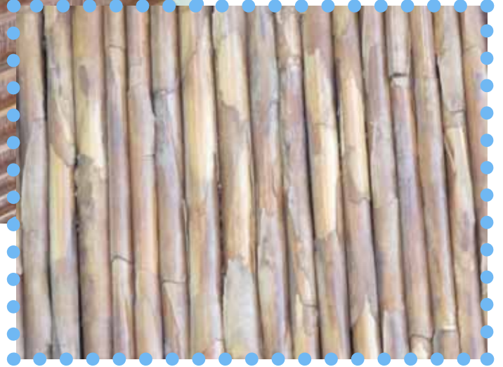
Figure 129- Utilisation de la canne en sous-face de la couverture : augmentation du confort en limitant la transmission de chaleur par rayonnement et convection (source : photographie personnelle)
