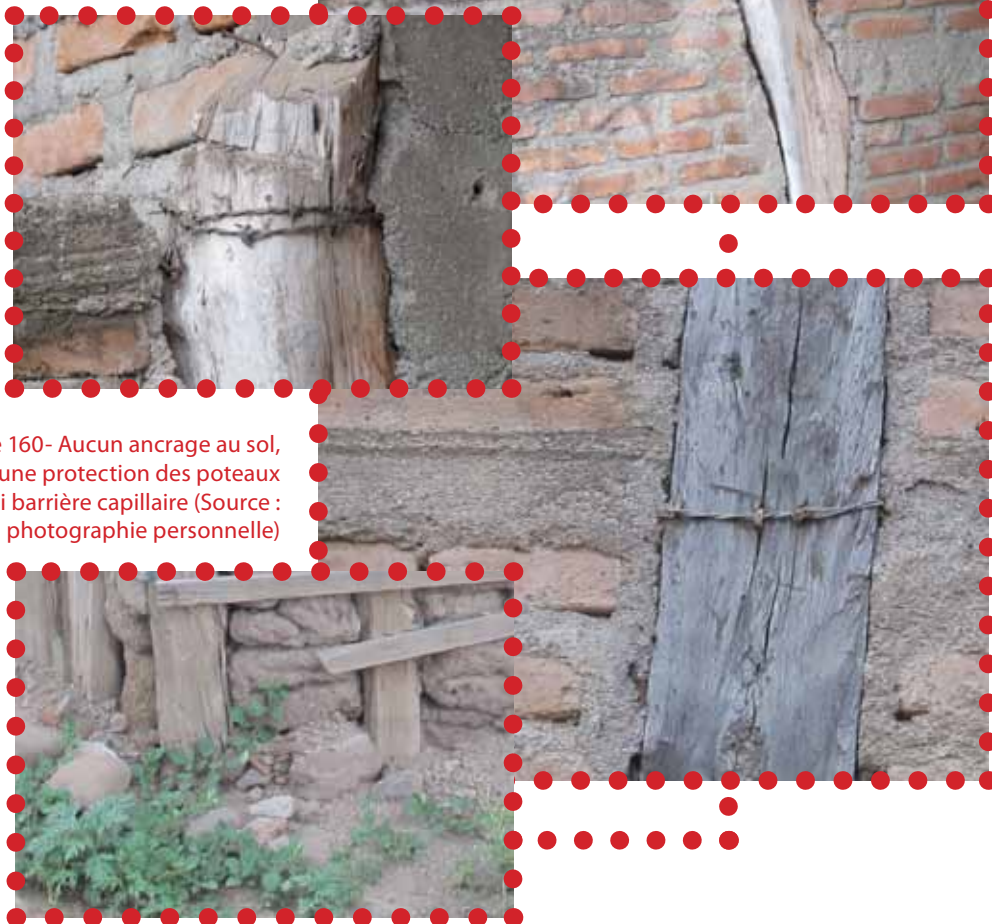
Figure 159- Assemblage douteux poteaux bois / poutre béton armé avec du fil barbelé. La continuité de la structure n'est pas assurée. Faiblesse de la jonction (Source : photographie personnelle)
