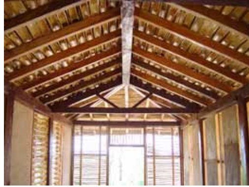
Figure 181- Vue de la sous-face de la toiture : structure charpente bois / lattis bambou (Source: Arch. Dulce Maria Guillen)
