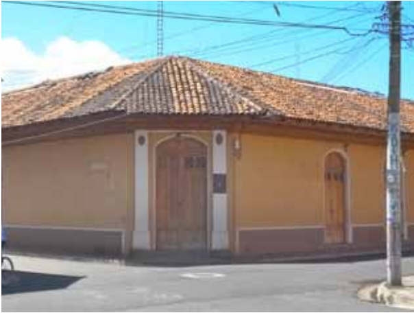
Figure 29- Habitation à Granada (Source : Suilan Hau)
