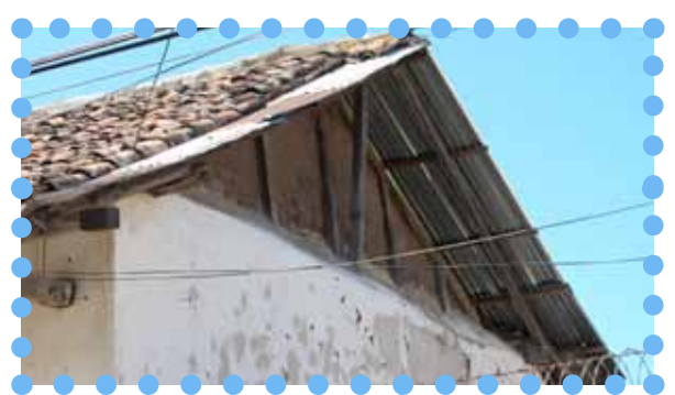
Figure 118- Détail du pignon en taquezal sur mur en adobe (Source : photographie personnelle)
