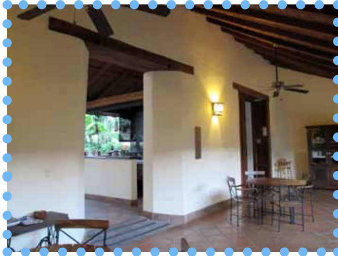
Figure 133- Hôtel El Patio del Malinche - maçonnerie porteuse à caractère antisismique : murs épais, ouvertures peu nombreuses, chaînages en bois (source : photographie personnelle)
