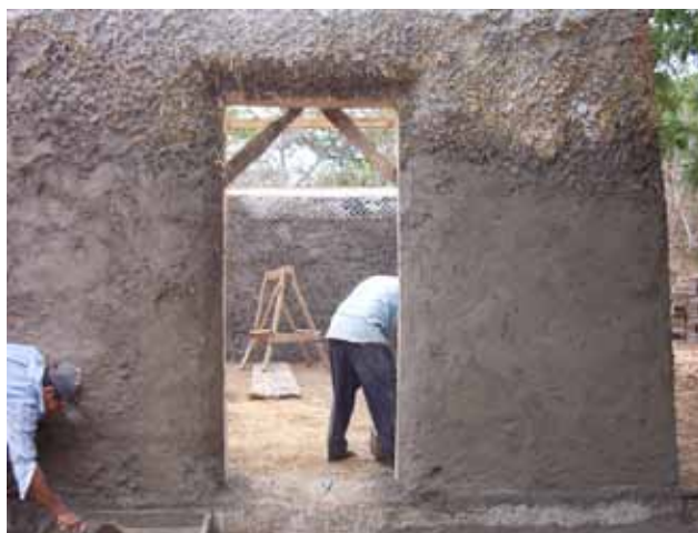
Figure 74- Pose de l'enduit en ciment (Source : Norman Padilla, ADIC)
