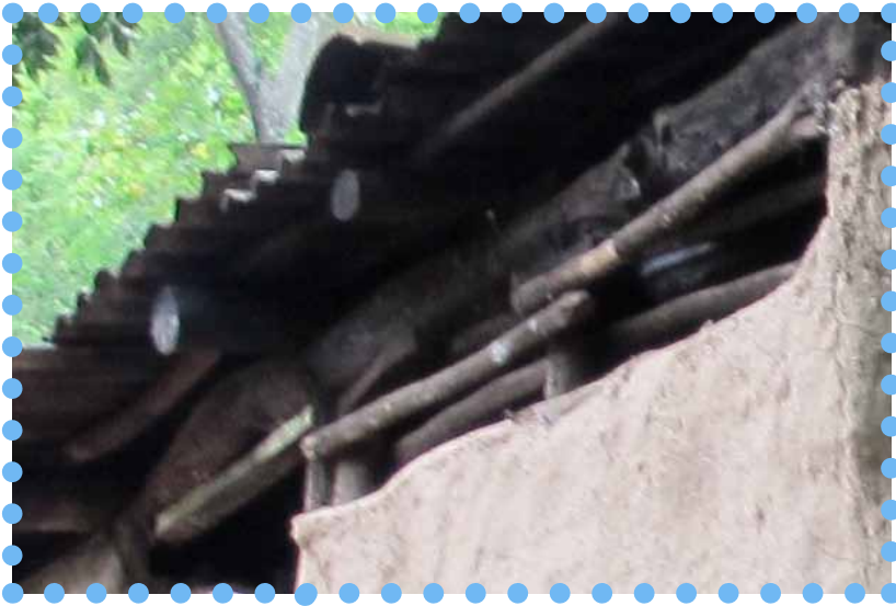
Figure 122- Détail de la structure tressée du taquezal albardeado (Source : photographie personnelle)
