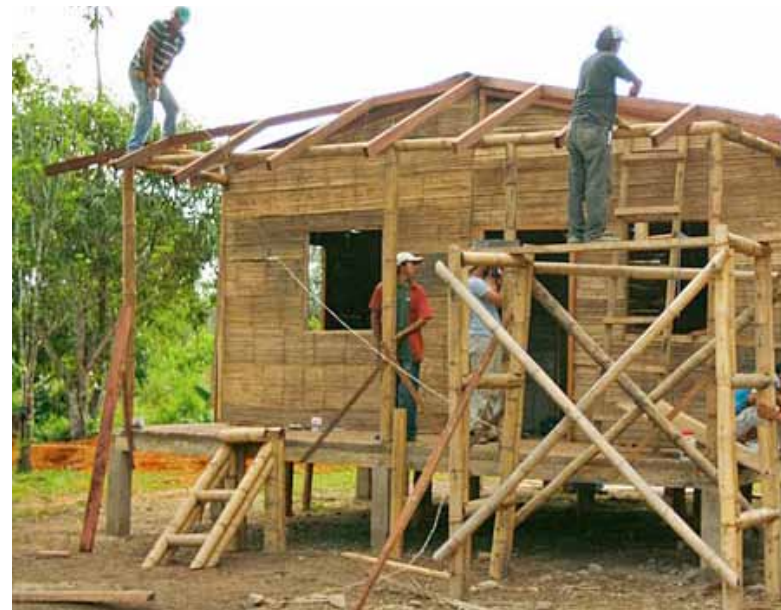
Figure 87- Montage de la structure (Source : CO2 Bambu)
