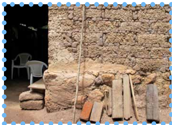
Figure 146- Totalement inondée, cette maison en adobe de plus de 50 ans a résisté à l'ouragan Mitch. Son soubassement et sa masse d'usure importants ont protégé l'intégrité de la maçonnerie (Source : photographie personnelle)
