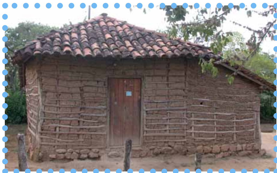
Figure 148- Malgré le dénuement apparent de cette habitation en taquezal , les murs sont très bien réalisés et en bon états. Bien qu'il soit bas le soubassement en pierre permet une bonne protection des pieds du mur et des poteaux en bois (Source : Arch. Dulce Maria Guillen)
