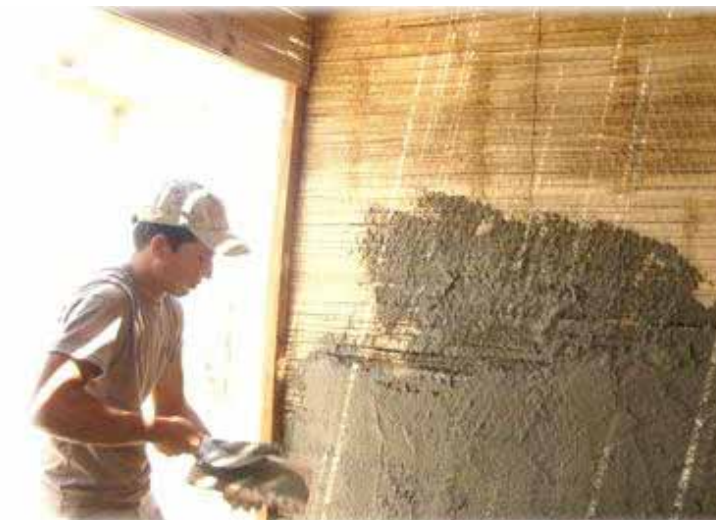
Figure 92- Pose de l'enduit en ciment sur les panneaux de bambou recouverts d'un grillage d'accroche (Source : CO2 Bambu)
