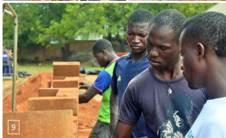
Photo 2 : exercice pratique et de dessin de plan du calepinage du mur en BTC
