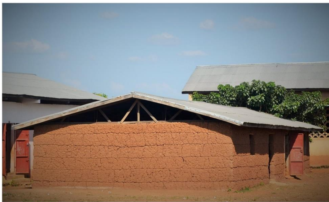
Salle de classe à l'EPP-Fako/Benin - Bauge/Banko maçon gôlier. Source : Mauricio Corba
