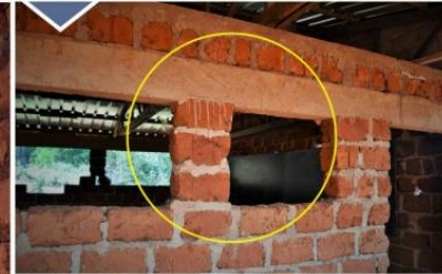
Salles de classe - Lycée Tchikang / Cameroun Adobe / chaînage en béton. Source : Mauricio Corba
