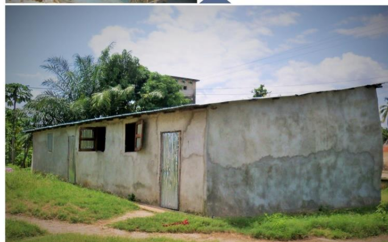
Salles de classe - CRETF Centre Régionale d'Enseignement Technique Feminin- Boucotte / Casmance / Sénégal Kirinting / enduit au ciment Source : Mauricio Corba
