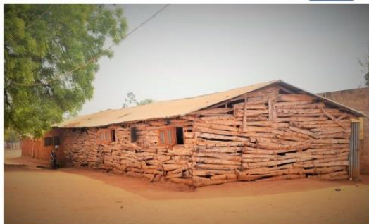
Salle de classe EPP - Benebalot I / Cameroun Planche et structure portique en bois. Source : Mauricio Corba
