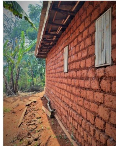
Salles de classe - Lycée Tchikang / Cameroun Adobe / chaînage en béton. Source : Mauricio Corba
