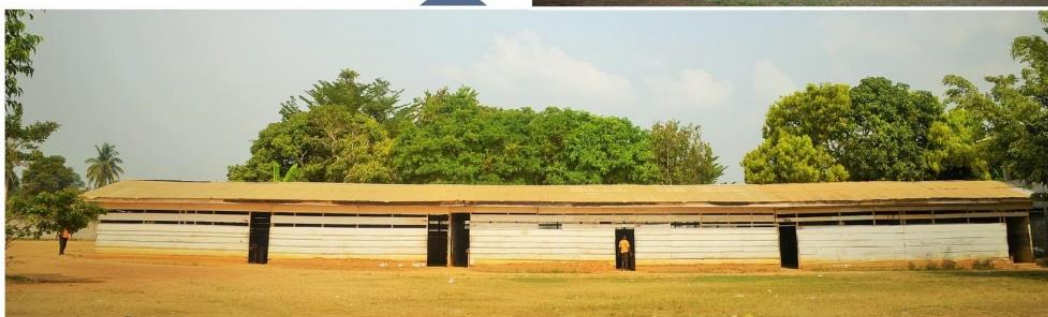
Salles de classe Lycée Technique - Mbalmayo / Cameroun Planche et structure portique en bois. Source : Mauricio Corba
