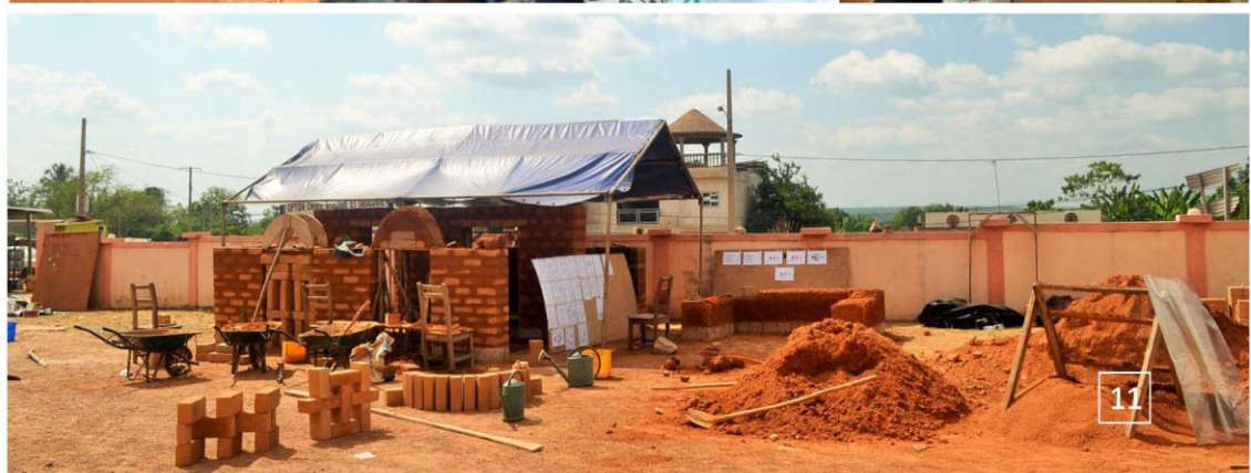
Photo 7 : construction d'un mur en bauge (banko/maçon gôlier)
