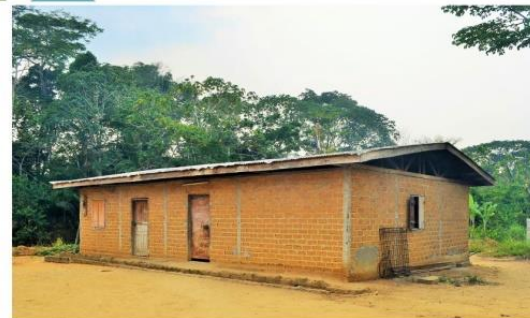
Maison rurale - Benebalot II/Cameroun BTC non stabilisé - structure portique en bois. Source : Mauricio Corba
