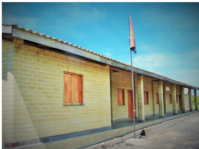
Modules des écoles qui ont été reproduits, construits à Gbela et Kibala après la formation de matériaux locaux. Source : Mauricio Ganduglia
