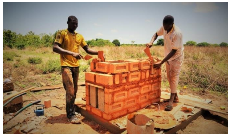
Incinérateur construit en BTC. Source : Pernelle Monteil
