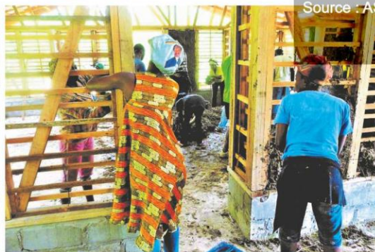
Photos du chantier de la cuisine en torchis
