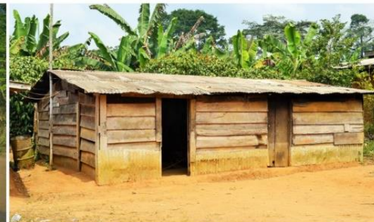
Maison rurale - Mengueme / Cameroun Planche et structure portique en bois. Source : Mauricio Corba
