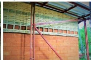
L'usage du Kirinting en haut de la boutique, en permettant la ventilation naturelle
