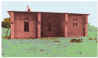
Photo 1 : exemple de l'habitat traditionnel au Burkina Faso. Figure 2 : Exemple de fiche d'inventaire des techniques constructives traditionnelles, produite dans le cadre du projet. Figure 3 et photo 4 : vues du modèle Yagma, génération 2. Figure 5, 6 et photo 7 : maison des enseignants développée dans le projet. Source : Craterre. Amélioration images : Mauricio Corba.
