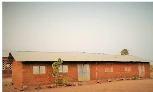
Maison rural - Degue-Degue/Benin Bauge/Banko maçon gôlier. Source : Mauricio Corba
