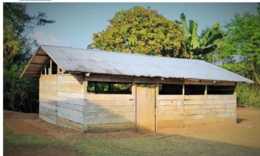
Salle de classe EPP - Benebalot I / Cameroun Planche et structure portique en bois. Source : Mauricio Corba
