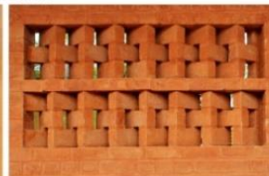
L'usage du Kirinting en haut de la boutique, en permettant la ventilation naturelle
