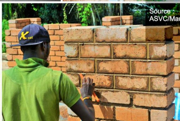
Photos du chantier des chambres en BTC
