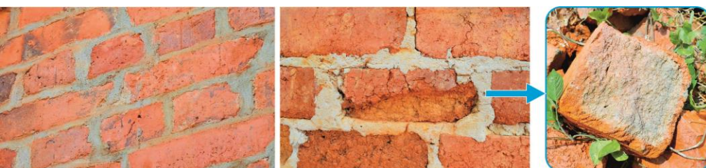
Photo à gauche : brique cuite (Couleur rouge) utilisé dans la construction de la Cathédrale Notre Dame du Rosaire à Mbalmayo – Cameroun, à l'époque de la colonisation. Source : Mauricio Corba.
