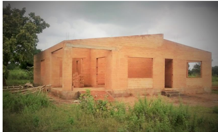
Maison privé, 3 chambres salon, construit en BTC. Source : Pernelle Monteil
