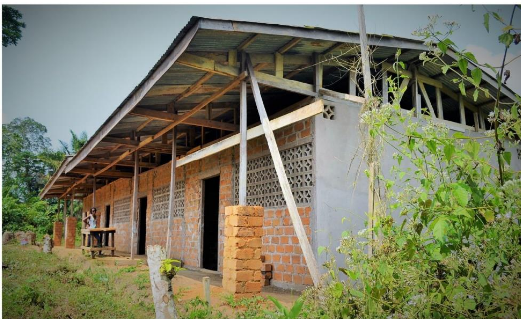
Maison rurale - Benebalot II/Cameroun BTC non stabilisé - structure portique en bois. Source : Mauricio Corba
