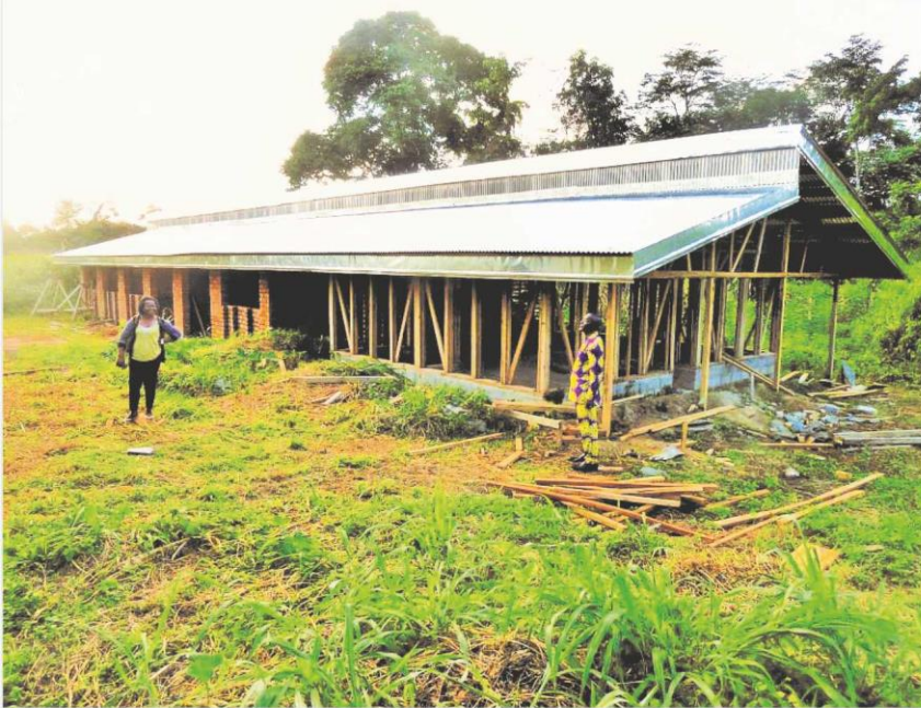
Vue générale du chantier du foyer d'accueil
