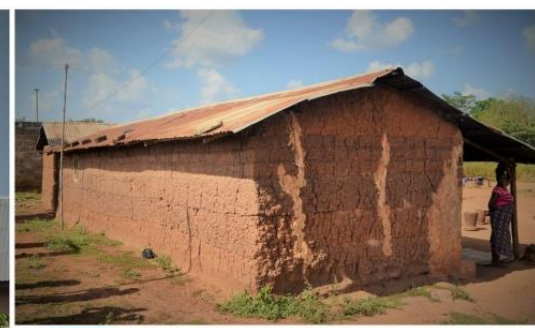
Maison rural-Bante/Benin Bauge/Banko maçon gôlier. Source : Mauricio Corba
