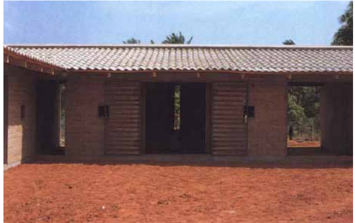
Toiture en tuile avec grands débords, School for Chicken Farmers, Localisation : Kindia, Guinea Architectes : HEIKKINEN & KOMONEN Finlande
