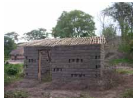
Maison en construction en Tshimba brique
