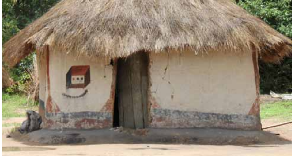
Murs en tshimba briques enduites et peintes sur la route de Sakania
