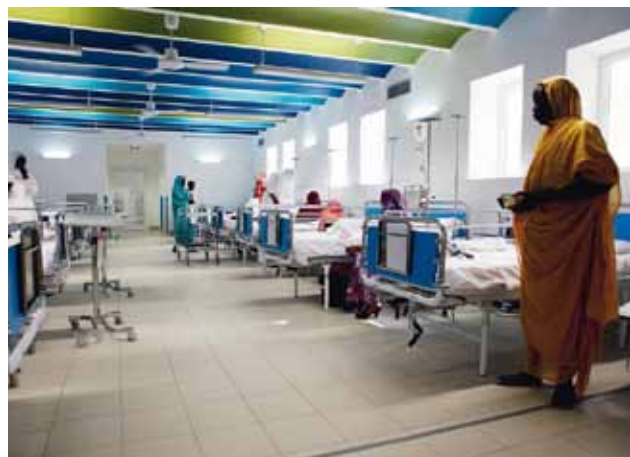
Utilisation de matériau léger en cloture et faux plafonds décoratifs, Emergency Pediatric Clinic, Darfurm Architecte: Raul Pantaleo, Tamassociati
