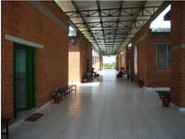
Circulation couverte dans le bâtiment des aspirants Salésiens, Viana, Angola Architecte : Maurizio GANDUGLIA
