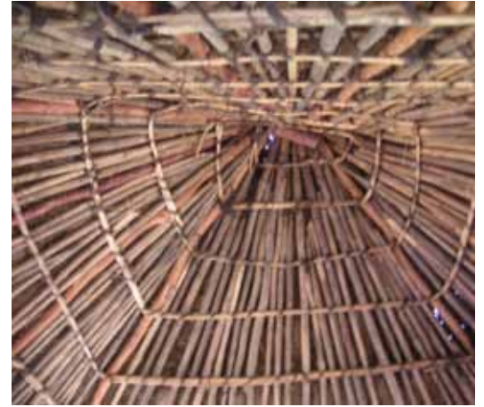
Toiture en paille et charpente bois/bambou, Habitat, Kipushia
