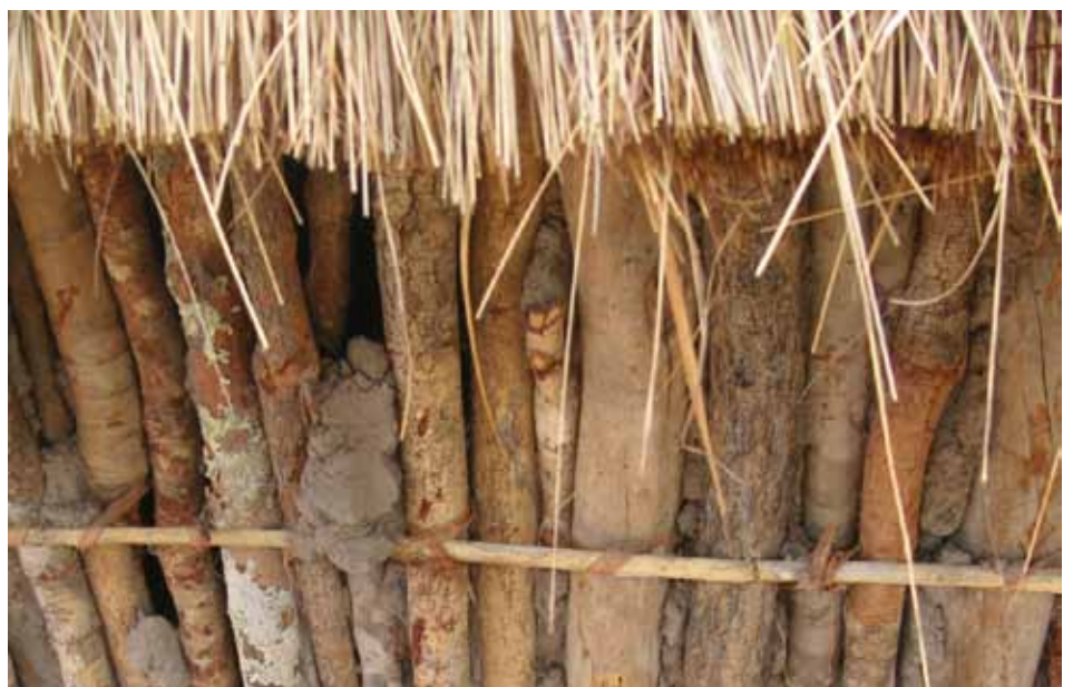
ossature bois, garnissage en terre sur la route Kipushia / Watemwa
