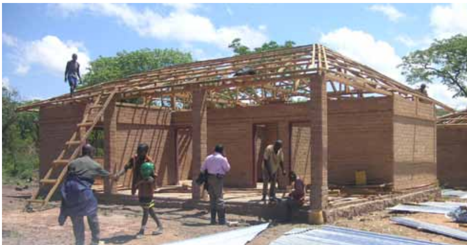
Centre de santé de Kalonga en chantier, novembre 2011
