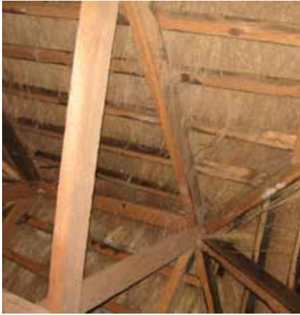
Toiture en paille et charpente bois, Paillote du restaurant Côte Ouest , Lubumbashi
