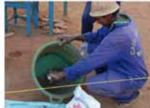
mortier épais - teneur en eau faible mortier épais - teneur en eau faible
