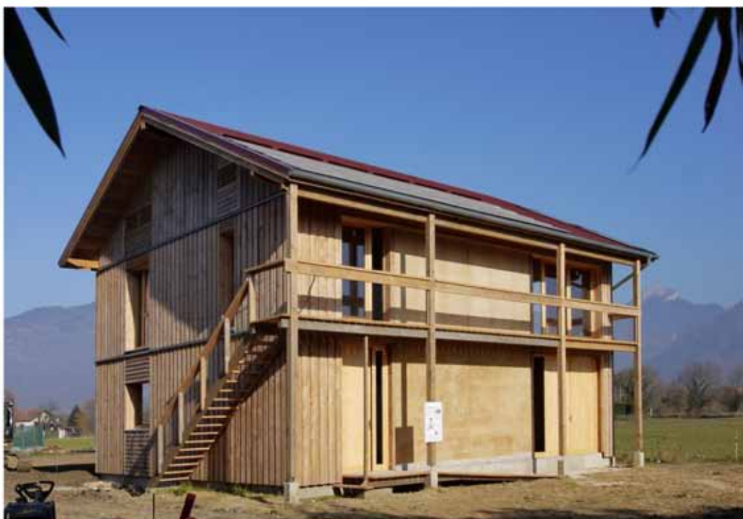
image à gauche: terre coulée à Sassenage - France- source: Caracol 23
