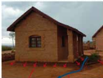
Pente en pied de mur Bit latein quas
