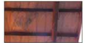
Les poches d'humidité provoquées par la bâche plastique sous-toiture. Les poches d'humidité provoquées par la bâche plastique sous-toiture.
